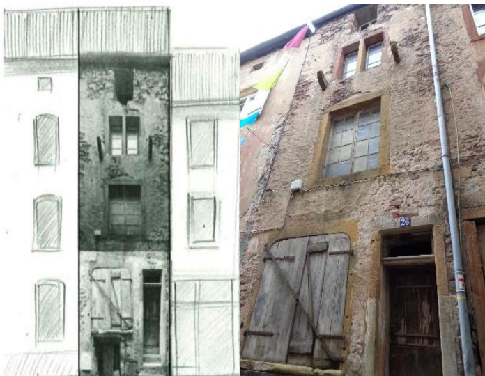
Exemple d'immeuble chandelle à rénover et restructurer à Sierck-les-Bains
