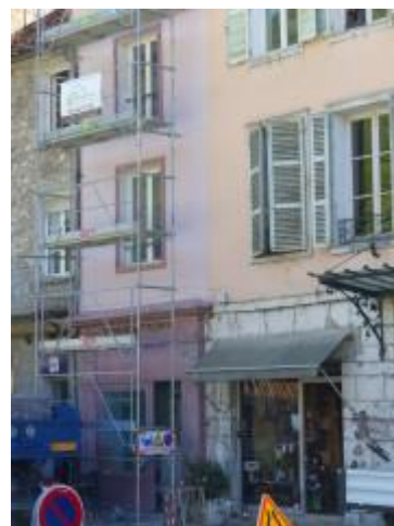
Immeubles à Salins-les-Bains en cours de réhabilitation
