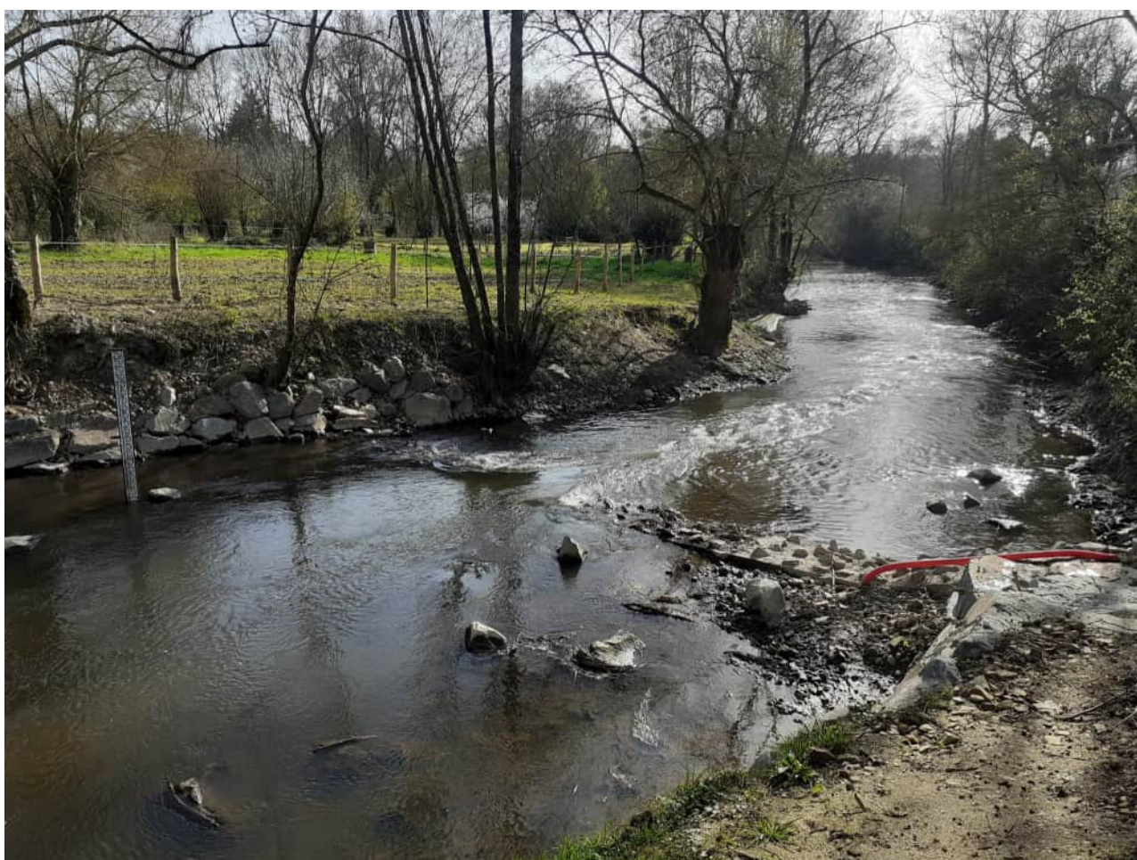
Station de Nort / Erdre (44) - 22/03/2022, suite à l'installation d'un seuil jaugeur franchissable par conception Établissement de la nouvelle courbe de tarage en cours
