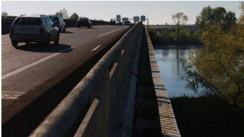
Le pont de Bellevue à Nantes. © Radio France - Romain Boulanger
