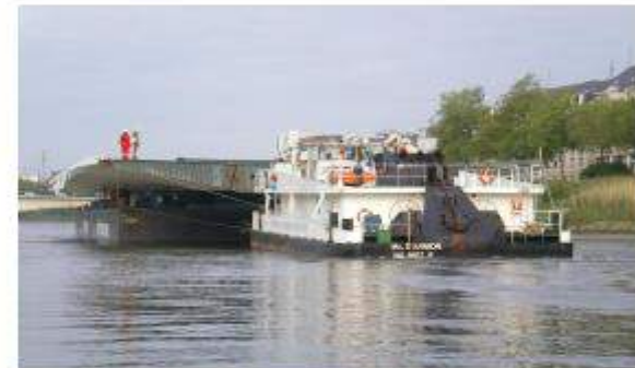
Mai 2010 - Acheminement fluvial du tablier pré-fabrique du pont Tiberly à Nantes
