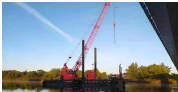
Les sondages sont réalisés à partir d'un ponton flottant positionné près du pont. © Photo DREAL
