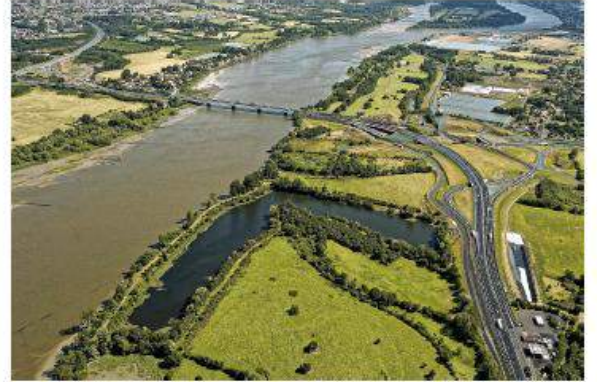
La photographie ci-dessous (issue du dossier de la concertation) montre le contexte du projet et l'interpénétration entre les espaces sensibles du bord de Loire, le quartier de Bellevue et les nœuds routiers importants (de part et d'autre du pont) qui constituent le « complexe de Bellevue » objet du projet.
