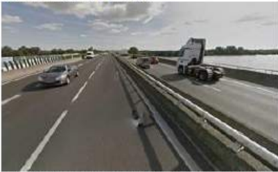
Le pont de Bellevue (ici dans le sens nord-sud) à Nantes. — Google street view
