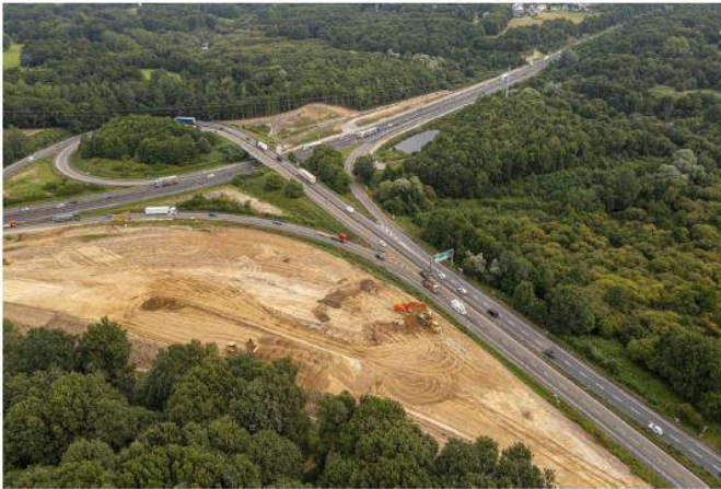
Les travaux de la porte de Gesvres à Nantes. (©Vinci Autoroutes)
