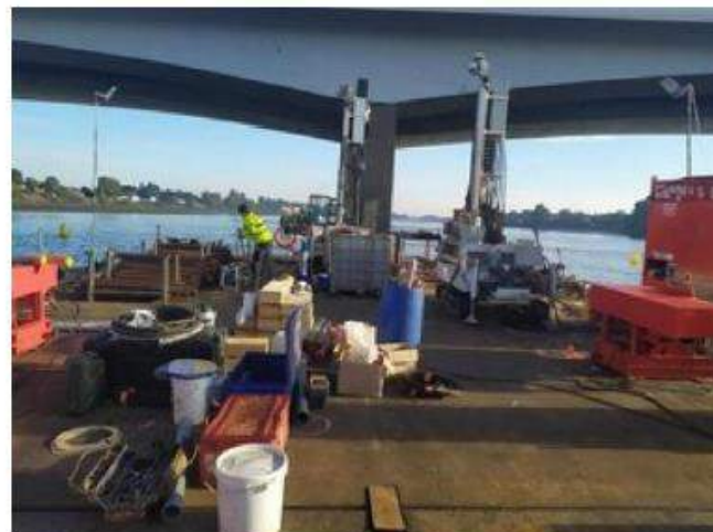
Les sondages sont réalisés à partir d'un ponton flottant positionné près du pont. © Photo DREAL
