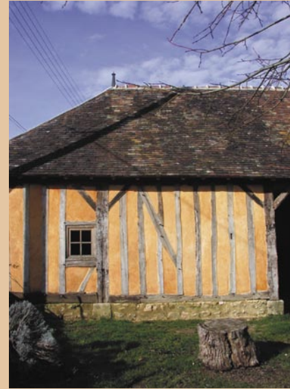
La restauration de ce bâtiment met en valeur la technique traditionnelle des colombages (photo du CAUE de la Sarthe).
