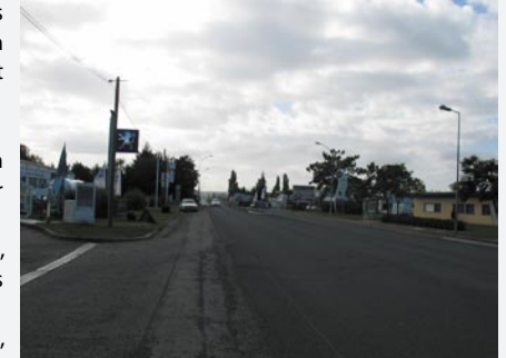
Entrée nord-ouest dans la Flèche
