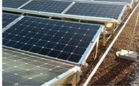
Orientation Est-Ouest : les panneaux sont installés en "papillon", le centre est le point le plus bas et les bords extérieurs hauts. Cette configuration permet un développement optimal de la végétalisation.
