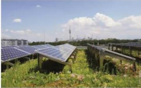
Orientation des panneaux vers le Sud : les panneaux sont tous orientés dans le même sens, vers le Sud et les lignes de panneaux sont espacées d'un mètre environ pour permettre un bon développement des végétaux.
