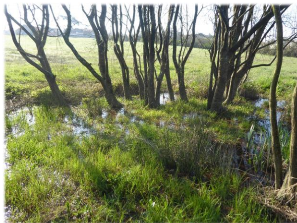
Emissaire hydraulique secondaire
