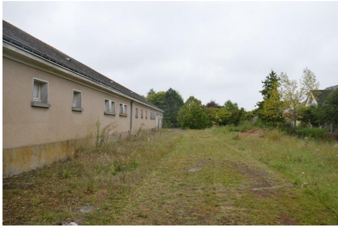
Espace en voie d'enfrichement
