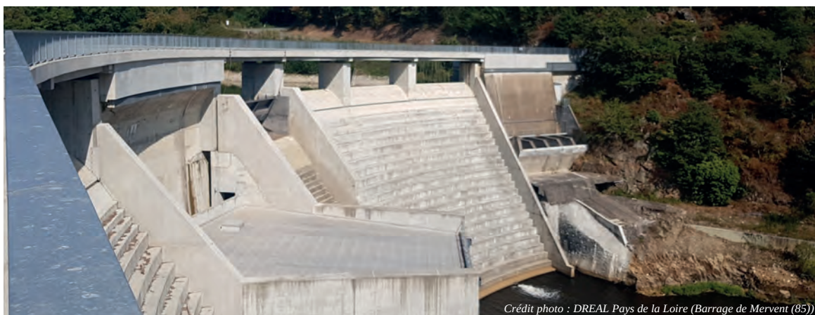
Crédit photo : DREAL Pays de la Loire (Barrage de Mervent (85))
