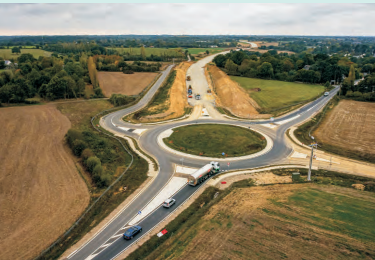
DREAL Pays de la Loire - déviation de Bouvron
