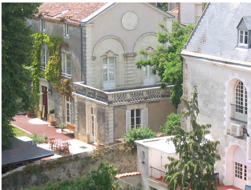
Vue sur la cour et la terrasse depuis le château
