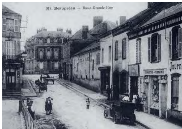
La Basse Grande-Rue, actuelle rue des Mauges
