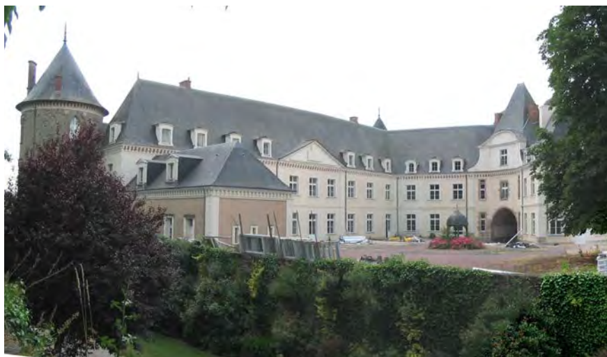
Cour intérieure du château
