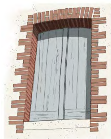
Linteau en arc segmentaire et harpage en briques 24, rue d'Anjou
