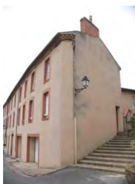
Escalier de la Poterne
