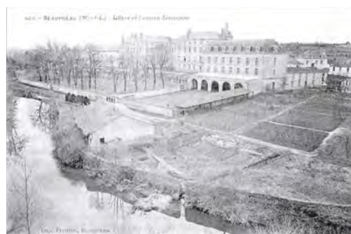
Vue sur le terrain arrière du collège et vue sur l'Evre
