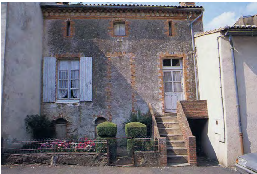
Le 10, rue Moreau avant sa restauration
