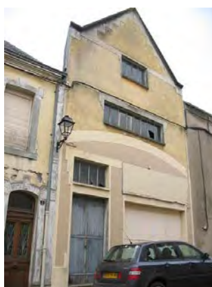
Ancien garage 3, rue du Commerce
