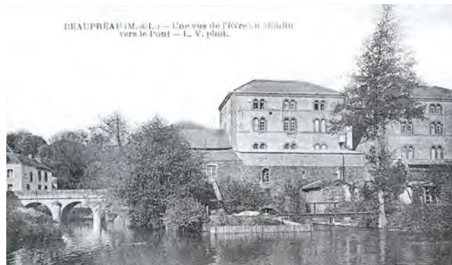
Les toitures sont ensuite habillées d'ardoises
