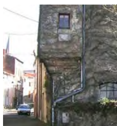
Encorbellement en pierre
