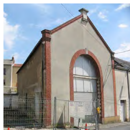
16, rue des Mauges, ancienne Maison Dupouet-Bigeard, négociants en quincaillerie-ferblanterie
