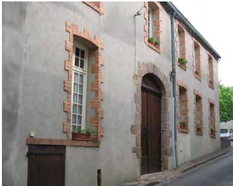
Façade des communs sur rue - encadrements de briques
