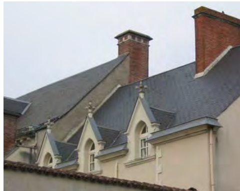
Façade arrière sur jardin
