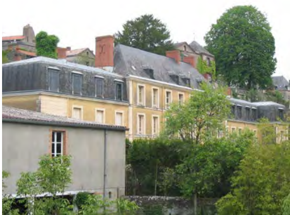
Façade arrière sur jardin
