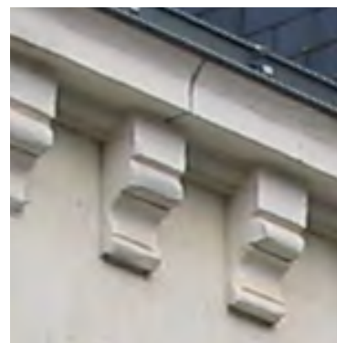
Modillons de calcaire
