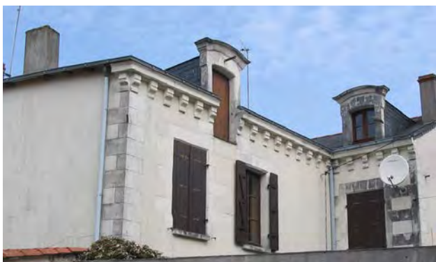
Etage supérieur et combles
