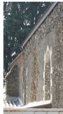
Vestiges des baies au n° 47
