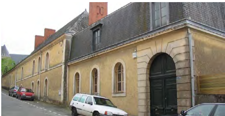
Façade donnant sur la rue Durfort de Civrac
