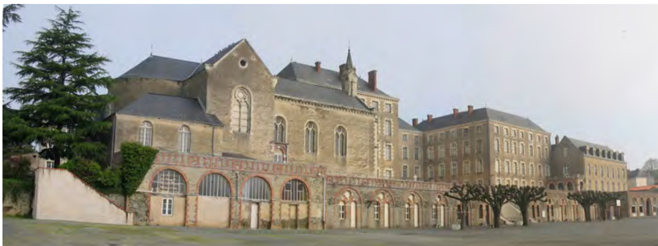
Vue sur les élévations sud du collège
