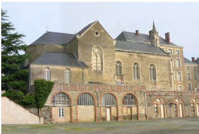
Façade sud de la chapelle
