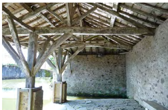
Charpente ancienne et murs de moellons de schiste
