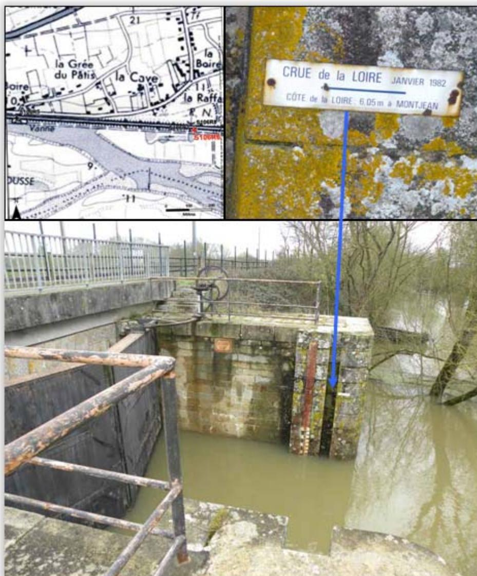
**Photo 1 : Repère de niveaux de crues de la Loire à côté du « pont éclusé » de la Raffardière (ouvrage supportant la voie ferré, marque de la crue de 1982)**
