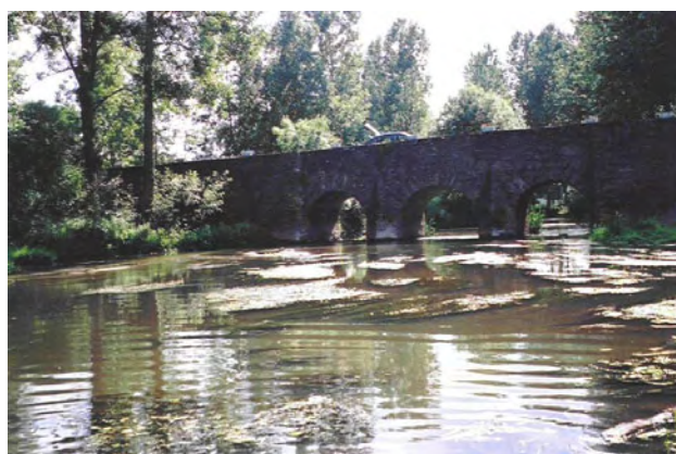
Vue aval de la station
