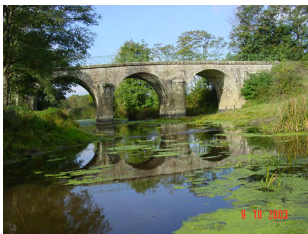
Vue vers l'aval
