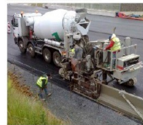
Machine de coffrage glissant
