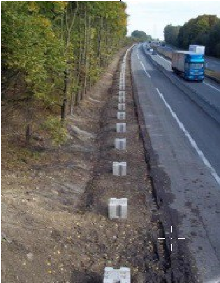
Pieux et tête de pieux
