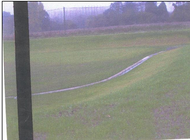
Photo 5 : Bassin paysager avec cunette centrale en béton dont le tracé rappelle celui d'un cours d'eau
