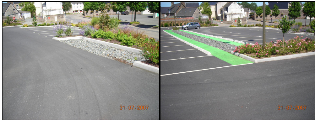
Photo 7 : Exemple de tranchées drainantes
