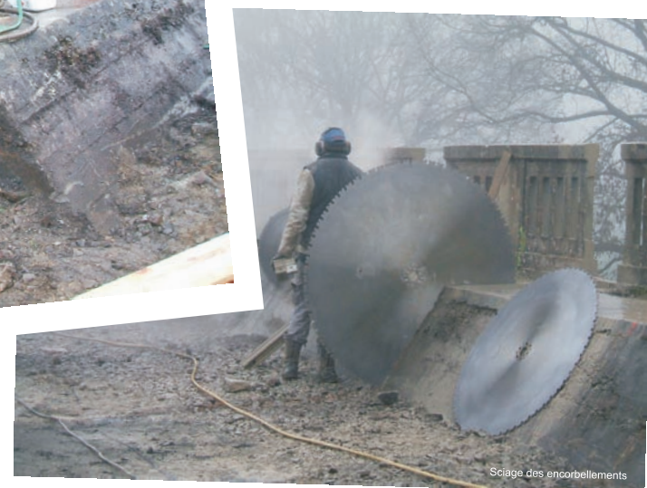
Sciage des encorbellements
