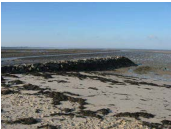
Entrée du port du Collet, épi en enrochements
