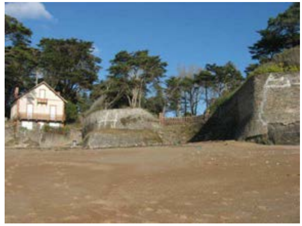
Perrés de protection des habitations
