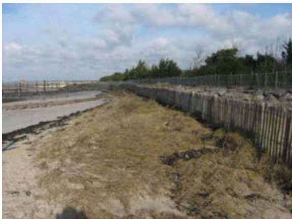
Au niveau du parking, système de deux rangées de ganivelles encadrant une dune embryonnaire végétalisée et une rangée de blocs
