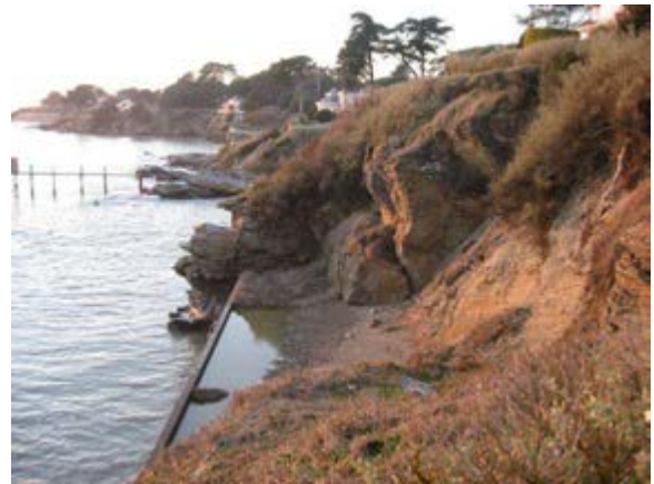
Glissement retenu par un perré et falaises légèrement sapées à la base
