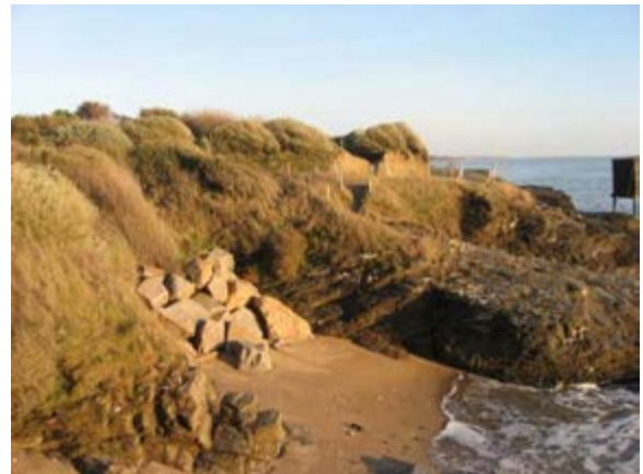
Enrochements en pied de falaise et sommet en érosion
