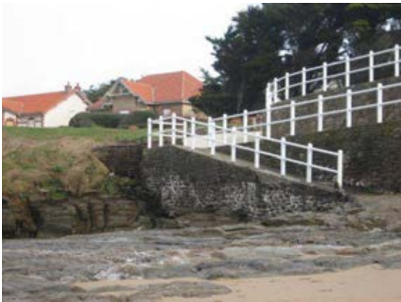
Accès PMR à la Plage de Préfailles et fascines retenant le talus
