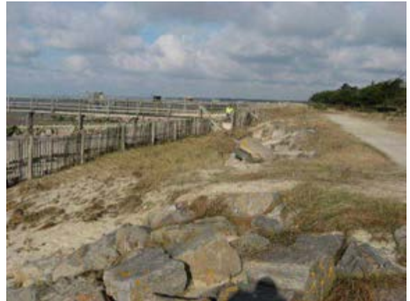
Perré en enrochements à la base de la dune, avec une rangée de ganivelles devant
