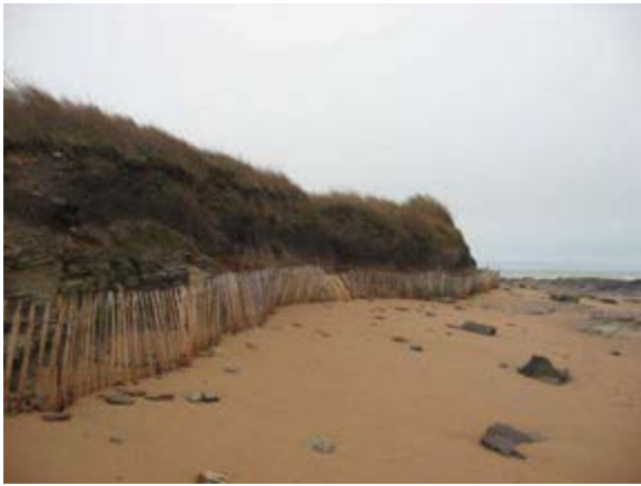
Ganivelles basculées et sommet du talus en érosion
