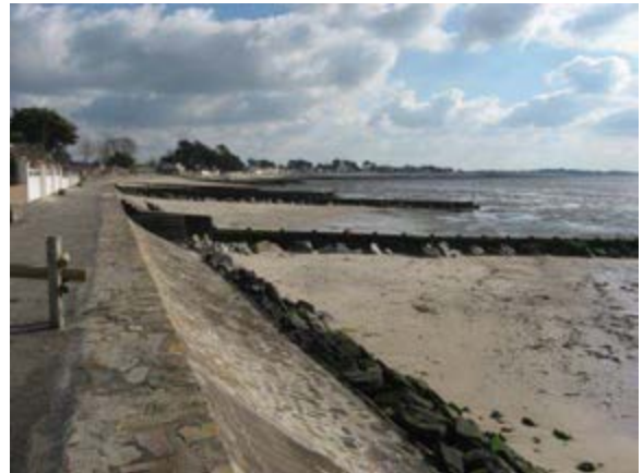
Plage de Pré Vincent, perré avec blocs en pied et promenade goudronnée en arrière
