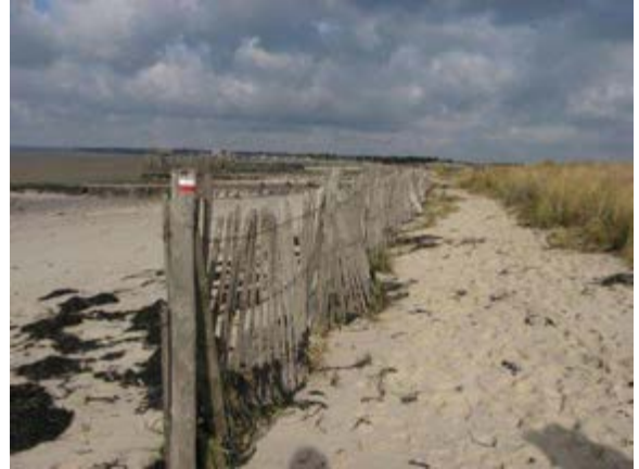
Sentier côtier canalisé, basculement des ganivelles
