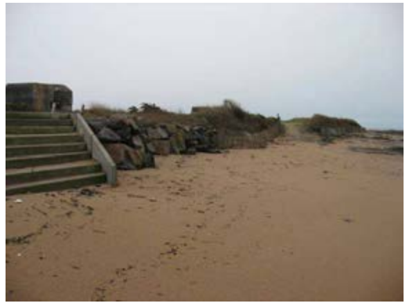
Accès escalier et rampe, présence d'enrochements puis de ganivelles
