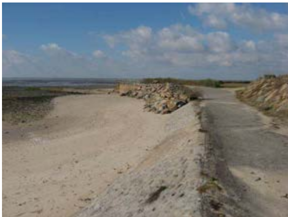
Perré maçonné et en enrochements à la pointe au-dessus des pêcheries
