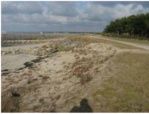
Perré en enrochements à la base de la dune, présentant quelques falaises d'érosion
