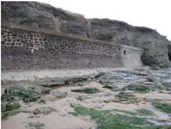
Anse du Sud: mur maçonné en pied de falaise
