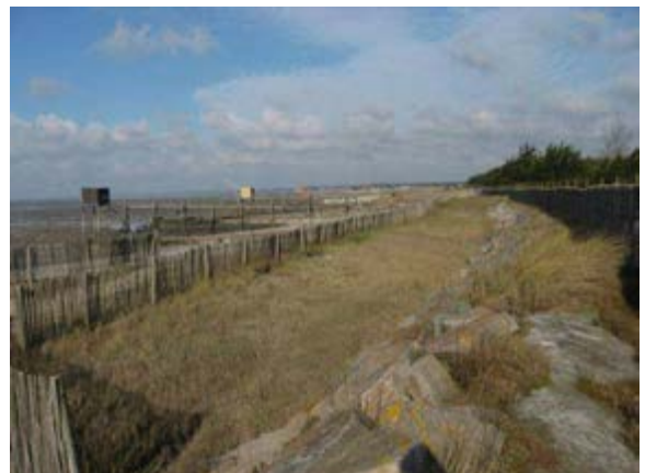
Au niveau du parking, système de deux rangées de ganivelles encadrant une dune embryonnaire végétalisée et une rangée de blocs
