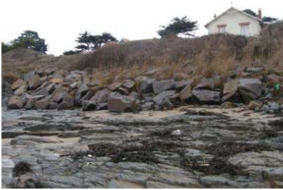
La Hutte. Enrochements en pied de talus
