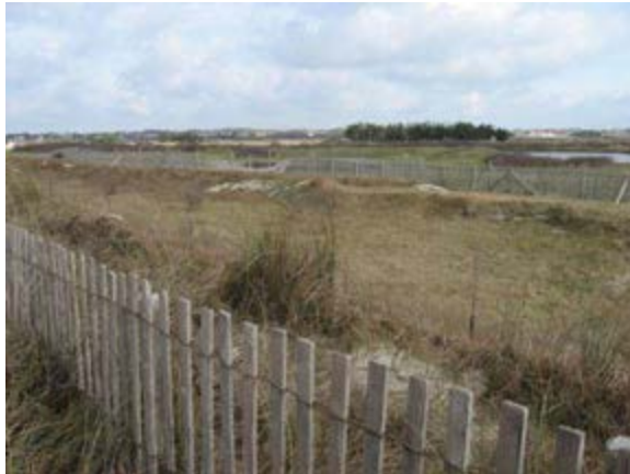
Dune en arrière du sentier littoral protégée par des ganivelles
