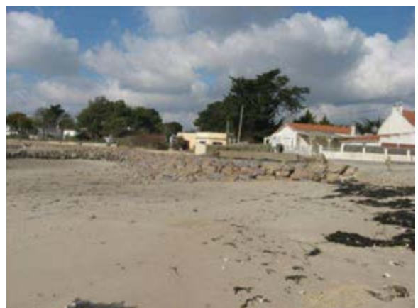
Perré en enrochements à la plage de Pré Vincent
