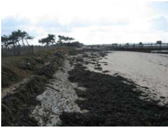
Au nord de la zone, perré en haut de plage ensablé et dont la partie sud entre les épis n'est jamais visible
