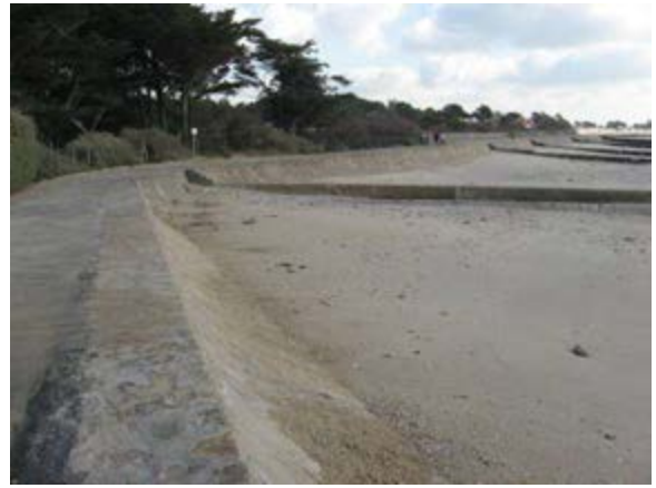
Vue depuis le camping de l'Ermitage vers le Nord (gauche), où le perré est affouillé à la base avec présence de blocs en pied, et vue vers le Sud (droite)
