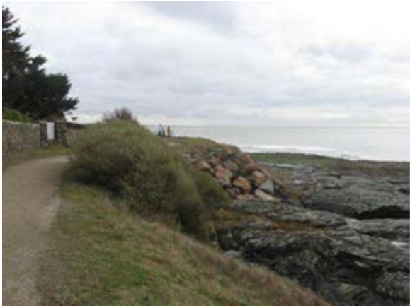
Enrochements contre la falaise après Margaret plage
