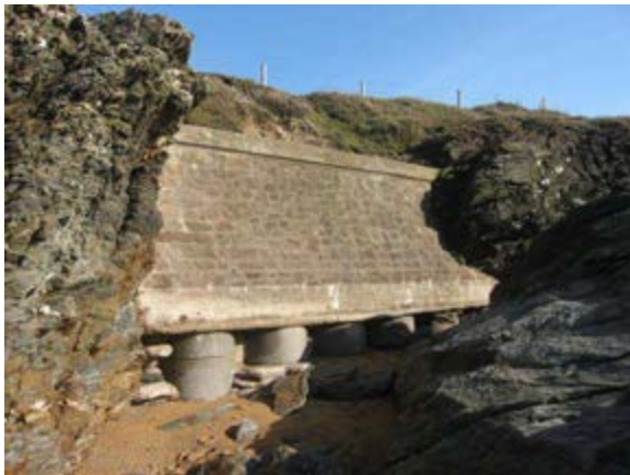
Mur maçonné de protection du talus
