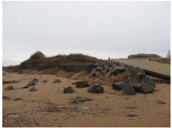
Cale de mise à l'eau et ganivelles basculées
