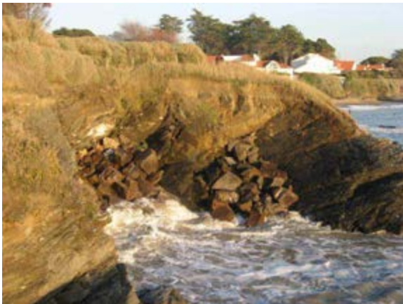
Enrochements en pied de falaise et sommet en érosion
