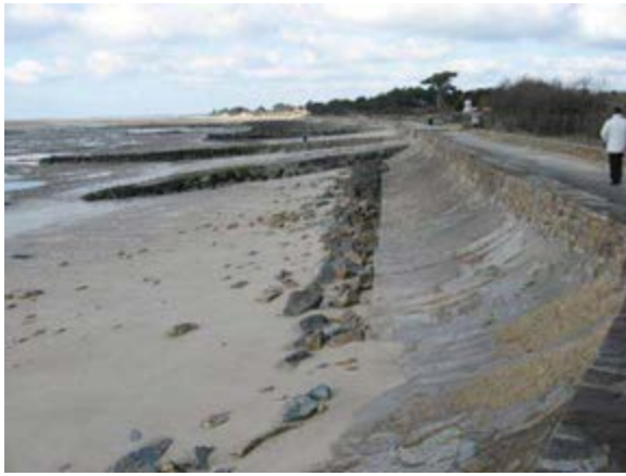
Vue depuis le camping de l'Ermitage vers le Nord (gauche), où le perré est affouillé à la base avec présence de blocs en pied, et vue vers le Sud (droite)
