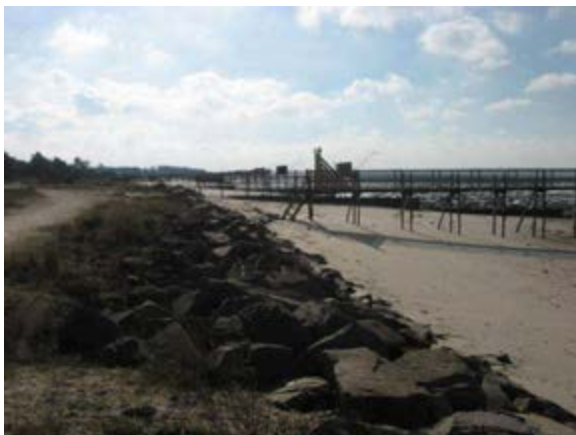
Vue vers le sud et perré en enrochements à la base de la dune
