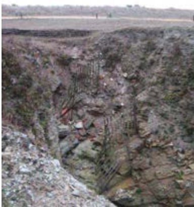
Ganivelles pour retenir les chutes de pierres
