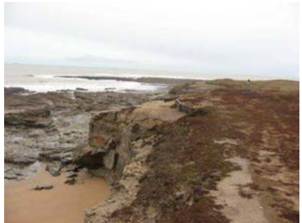
Système de fascines sur le sommet
