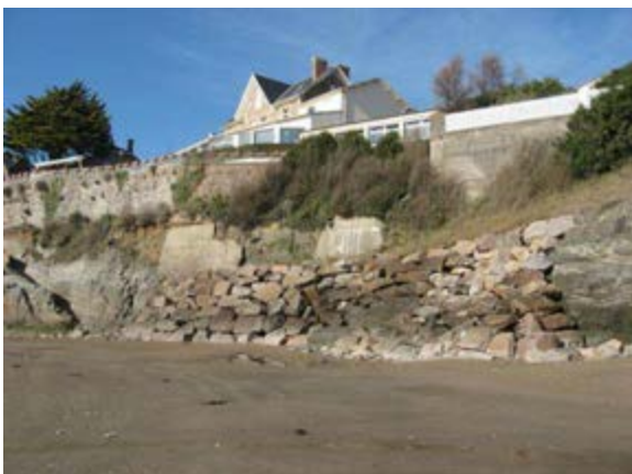
Perré en enrochements
