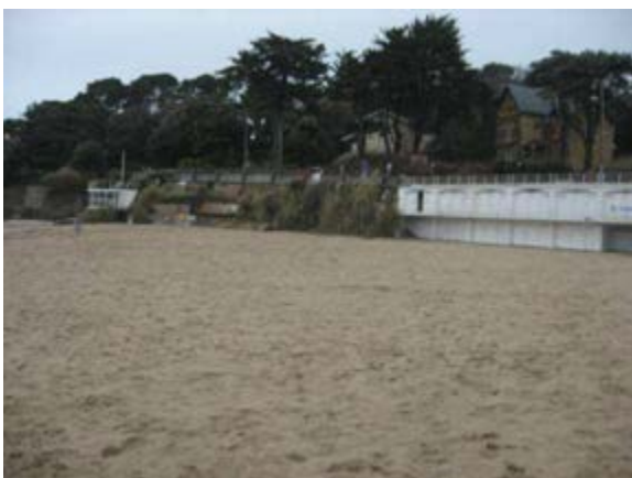
Cabanes de plage et restauration du perré à la Plage de la Noëveillard
