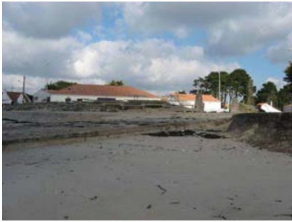
Cale de mise à l'eau à la plage de Pré Vincent
