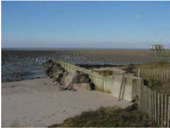
Epi en bois conforté au Sud par quelques blocs
