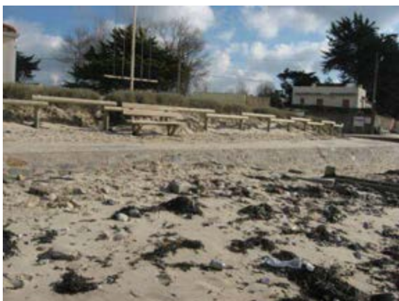
Perré enseveli du côté de l'épi, accumulation de sable
