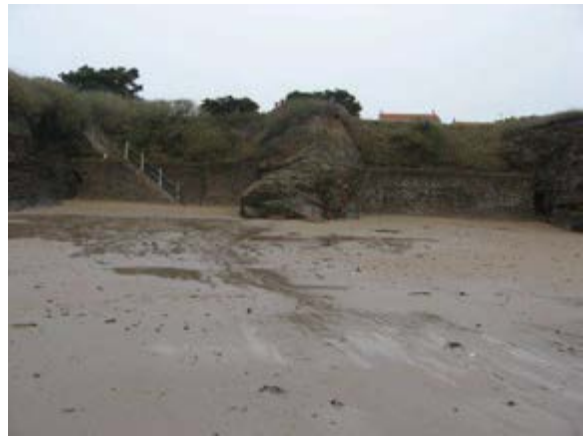
Anse du Sud: accès escalier et mur vertical
