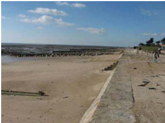
Plage de la Sennetière, au Nord, perré incliné avec promenade, épis renforcés par des enrochements côté sud
