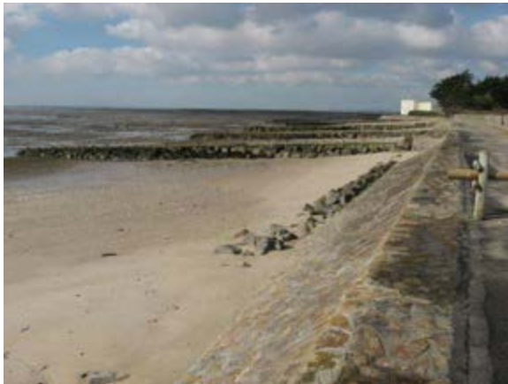
Plage de Pré Vincent, perré avec blocs en pied et promenade goudronnée en arrière
