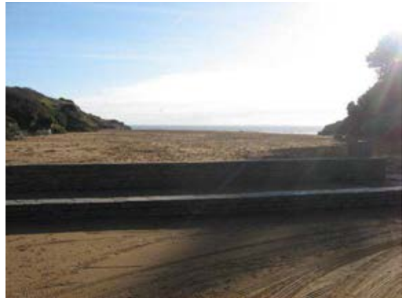
Plage du Porteau, ouvrage bas retenant le sable, large berme plate puis pente forte
