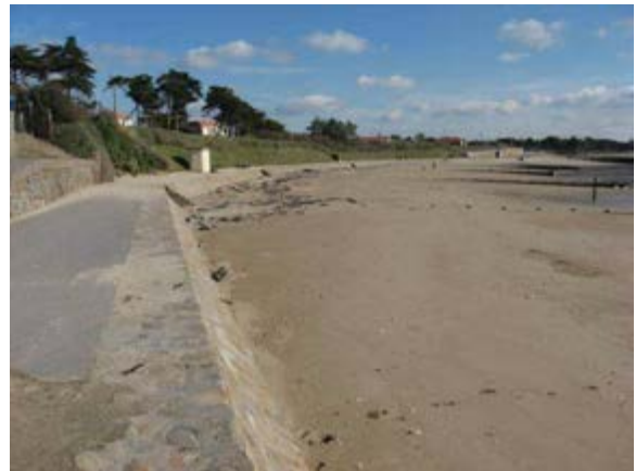
Plage de la Sennetière, au Nord, perré incliné avec promenade, épis renforcés par des enrochements côté sud
