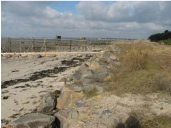
Perré en enrochements à la base de la dune, avec une rangée de ganivelles devant
