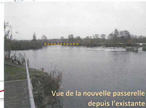
Implantation de la nouvelle passerelle
