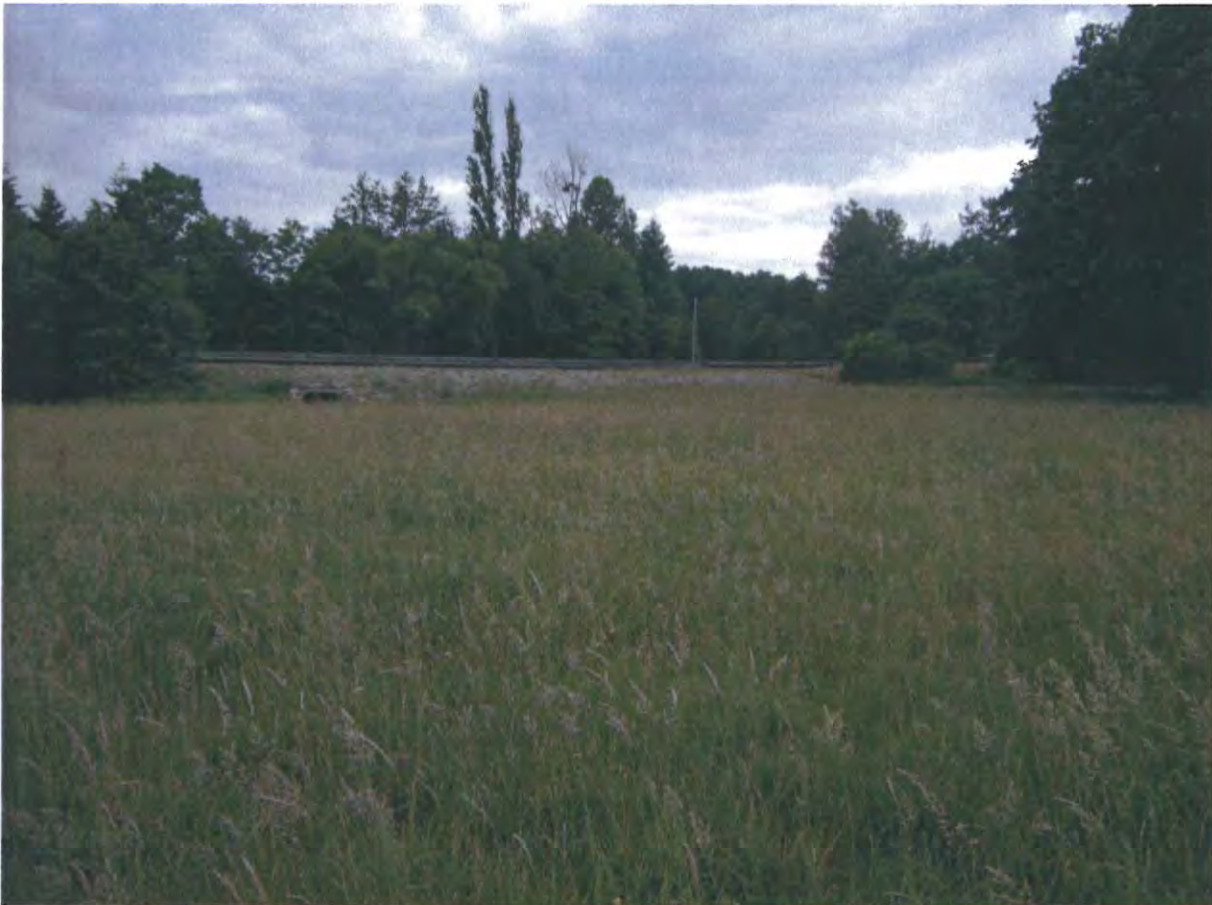
Le pont cadre sur le bras est de la rivière, vue de l'aval
