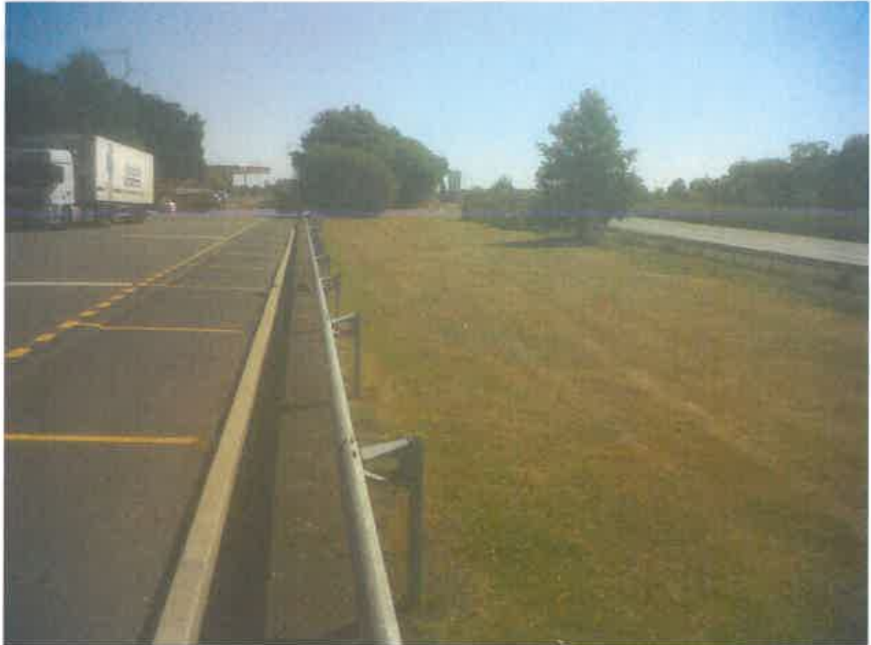
Vue n° 1 : vue depuis parking VL du Sud de l'aire de service
