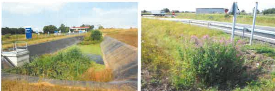
Aperçus des bassins de rétention aux abords de l'aire de service
