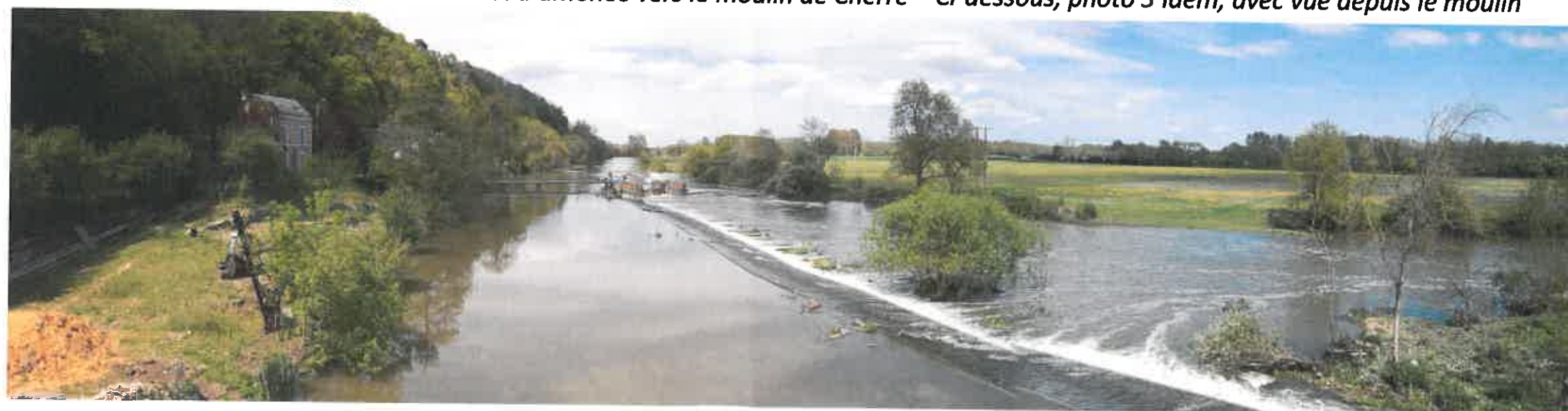
Photos 2 – Seuil déversoir créant un canal d'amenée vers le moulin de Cherré – Ci-dessous, photo 3 idem, avec vue depuis le moulin
