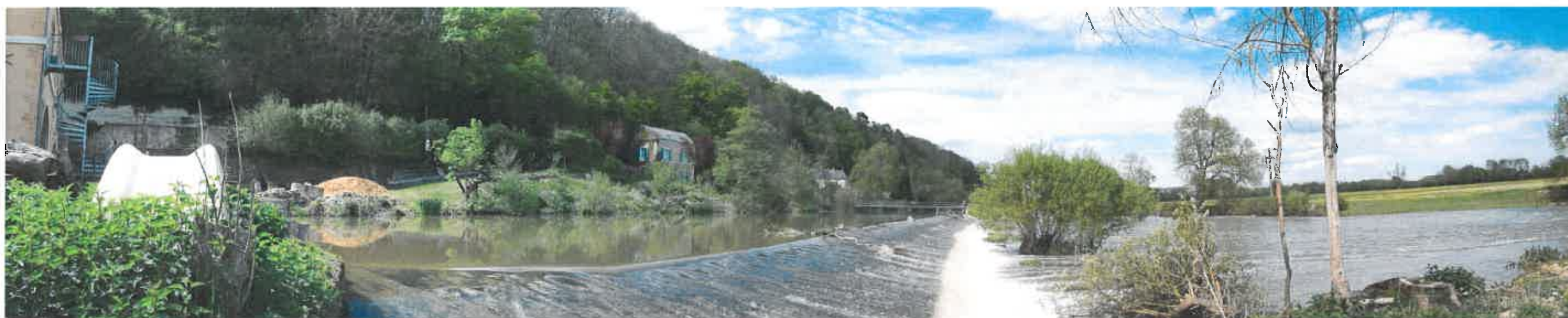
Photos 4 – Seuil déversoir créant un canal d'amenée vers le moulin de Cherré – Vue depuis l'île centrale
