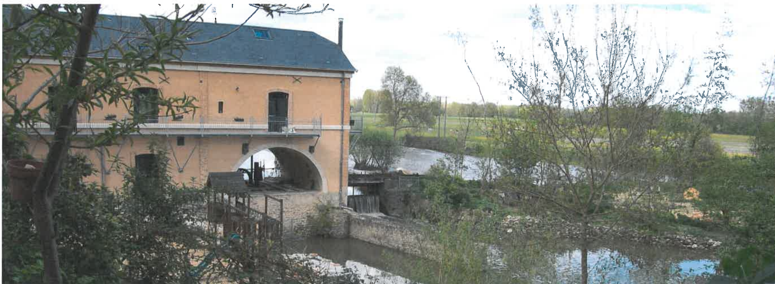
Photo 5 – Vue aval, canal de fuite et vannes de décharge en rive droite et île du propriétaire
