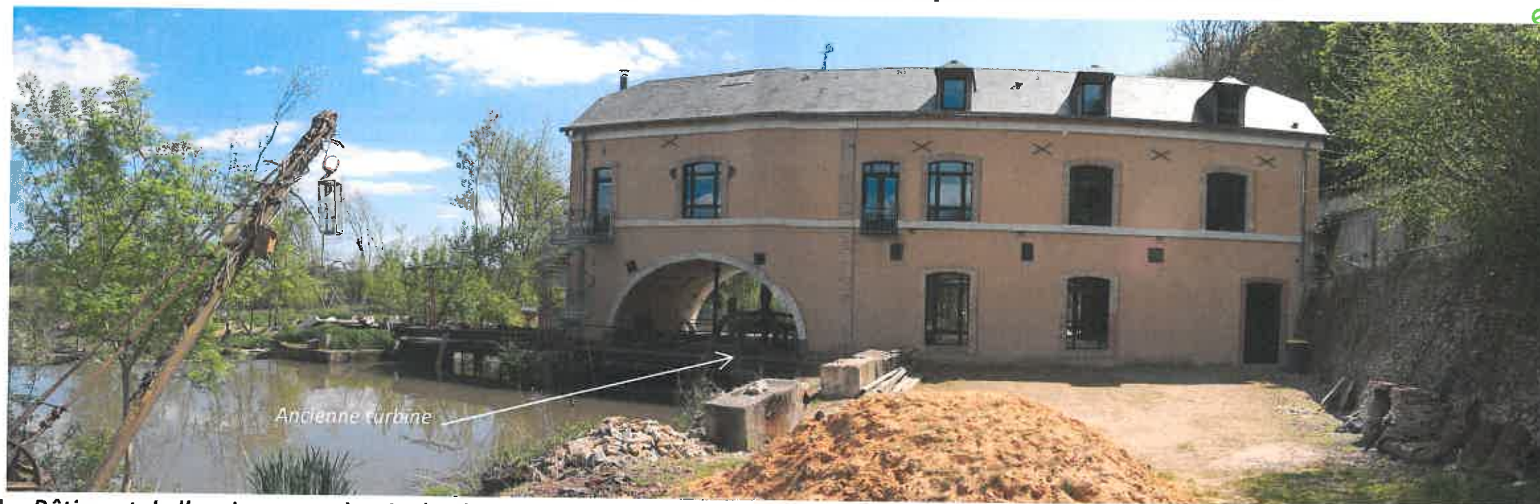
Photo 1 – Bâtiment de l'ancienne papèterie de Cherré avec la passe usinière et celle de décharge accolée au « moulin » en rive droite – Vue amont du Loir
