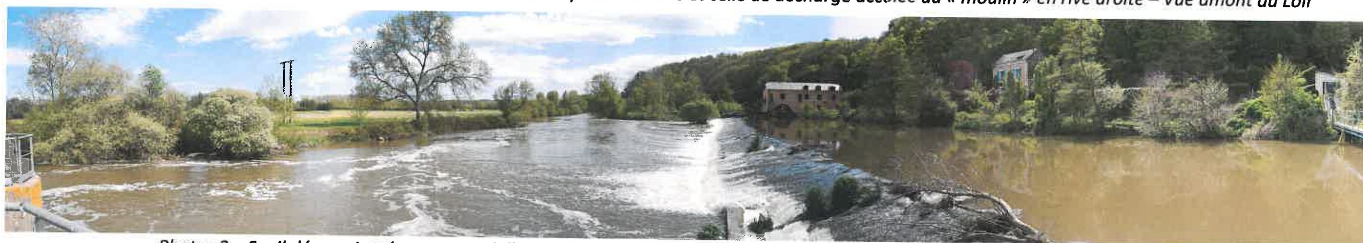
Photos 2 – Seuil déversoir créant un canal d'amenée vers le moulin de Cherré – Ci-dessous, photo 3 idem, avec vue depuis le moulin
