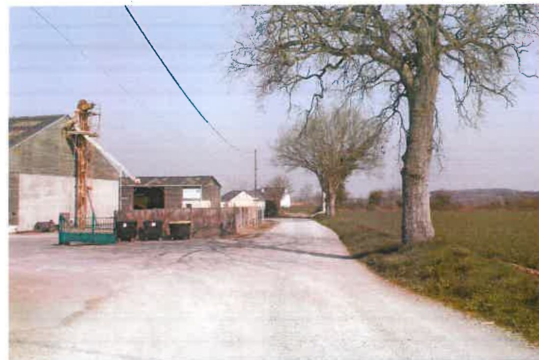
Photo 2 (P2) : vue sur l'accès à la future route d'accès à la déchèterie depuis la RD103
