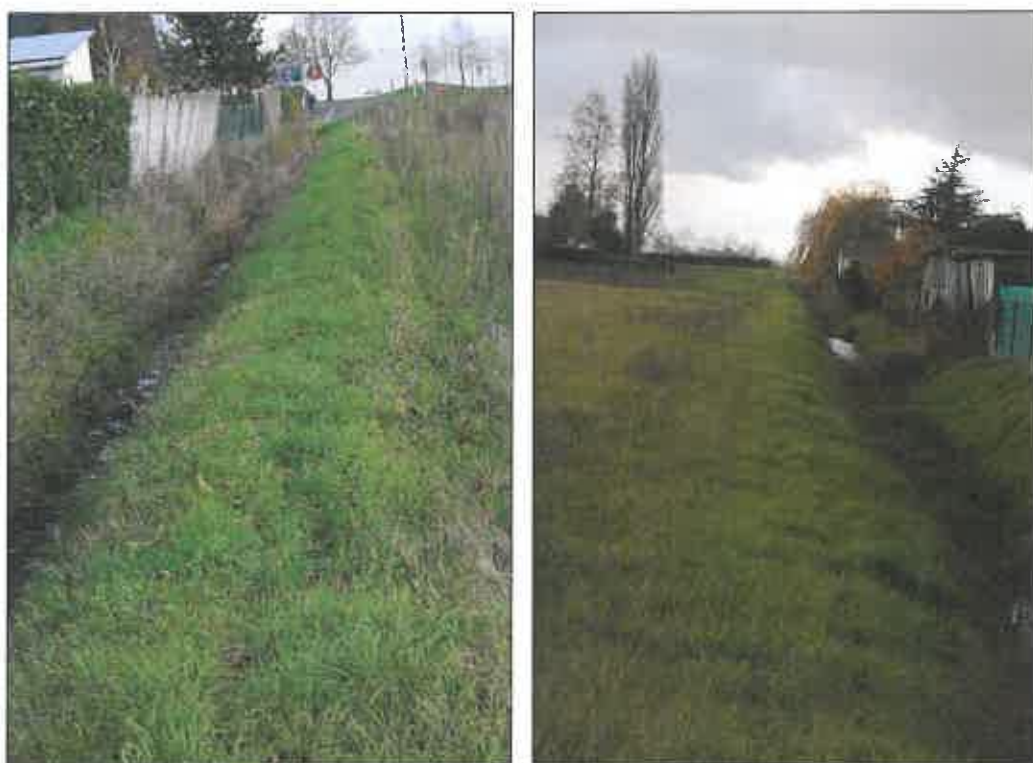
Vue n° 5 et 5' : vues du fossé existant en amont du projet
