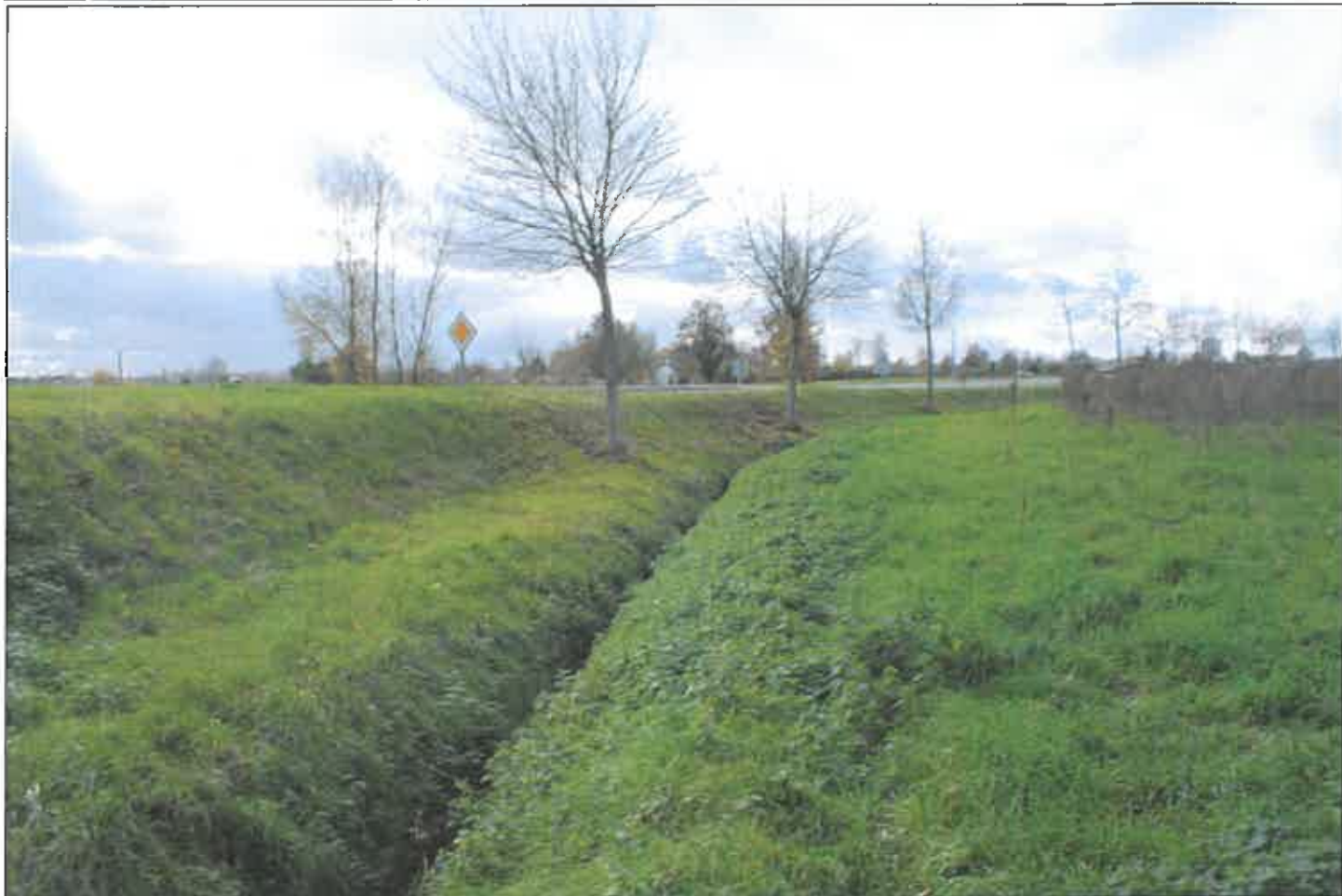
Vue n° 3 : vue du fossé de la DR 79
