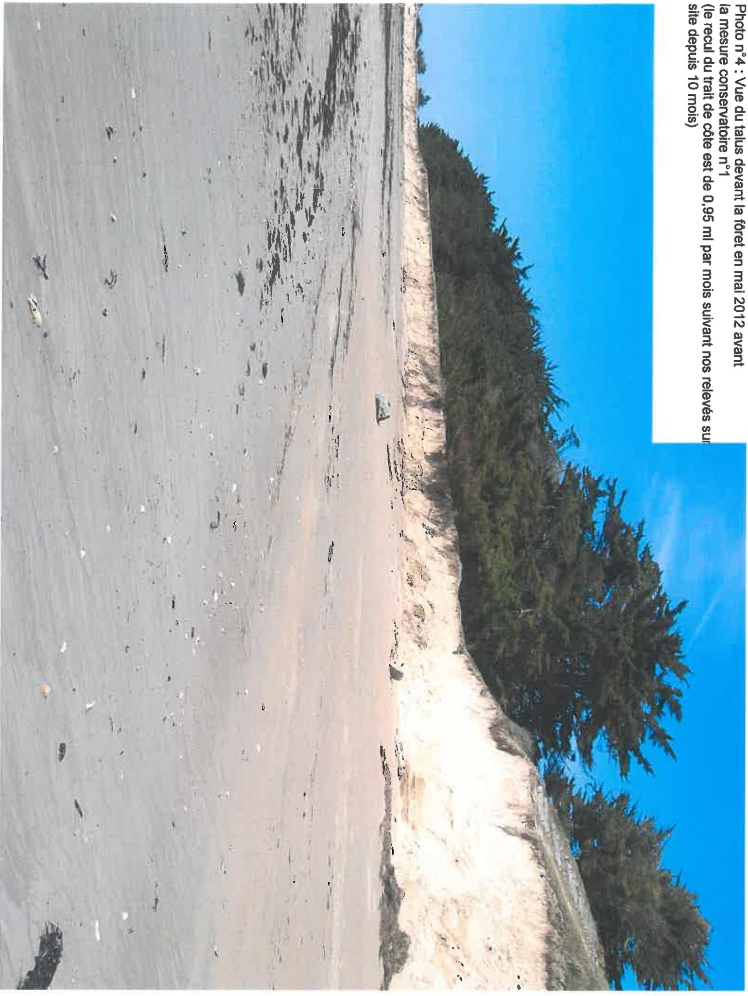
Photo n°5 : Vue du talus devant la culée en mai 2012 avant la mesure conservatoire n°1 (le talus devant la culée sert à reprendre en partie des efforts de la précontrainte des aciers dans le tablier)
