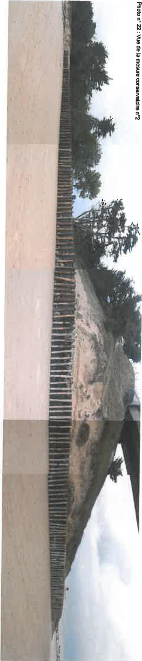
Photo n°23 : Vue de la mesure conservatoire n°2 (renforcement de la pointe de la Fosse pour éviter une nouvelle pénétration des eaux sous le parking)
