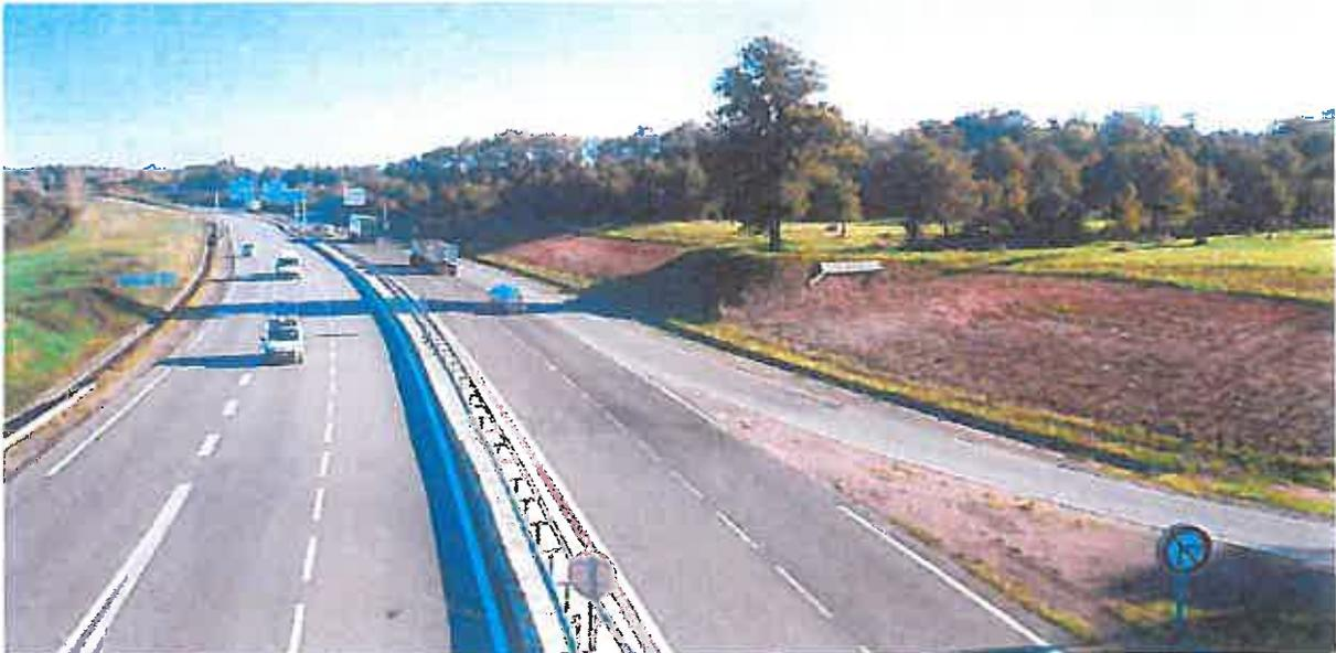
L'accès à la D6 se fait en venant de La Roche sur Yon par un échangeur avec ouvrage de franchissement supérieur et depuis Challans par une voie de décélération débouchant sur un giratoire annonçant l'entrée de la zone.
