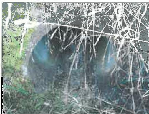
Buse de 500 mm, assurant la traversée des eaux sous la voie, au nord-est.
