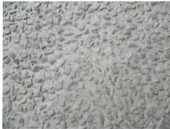
Photographie d'un béton désactivé
