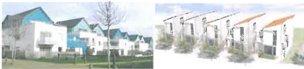
Exemples de logements semi collectifs
