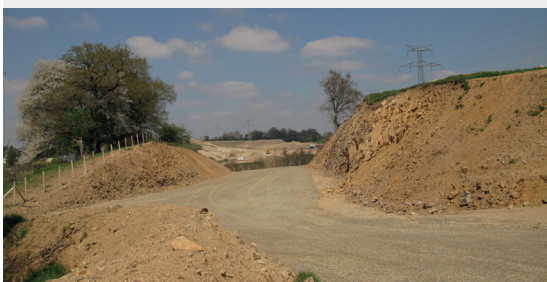
Pré-terrassements du viaduc
