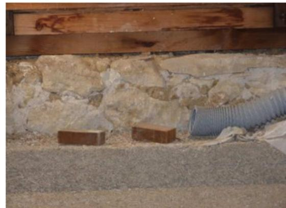
Figure 2-6 : Gaine de ventilation souple
