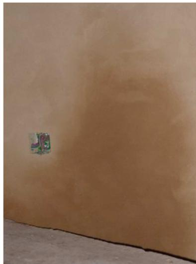
Figure 2-3 : Enduit de finition terre en cours de séchage
