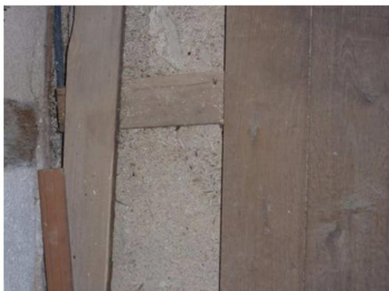
Figure 2-20 : Pose en cours du parquet du 1er étage, laissant apparaître le chaux-chanvre
