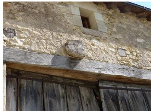
Figure 2-17 : Poutres existantes apparentes (façade Ouest)
