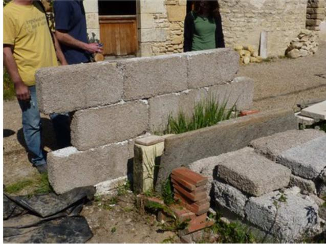
Figure 2-15 : Mur en chanvre maçonné à la chaux
