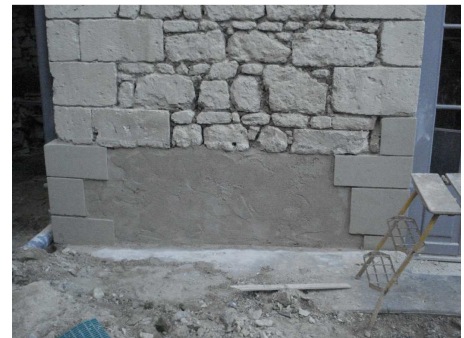
Figure 1-9 : Remplacement de pierres
