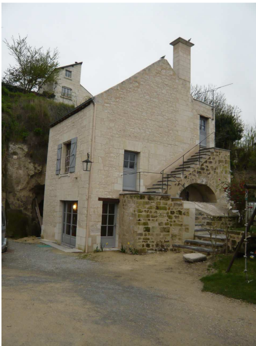
Figure 1-1 : Prise de vue Sud-Ouest
