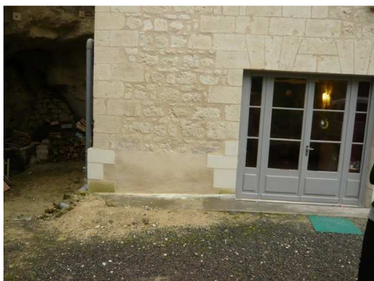
Figure 1-11 : Façade avec traces de moisissures (en bas à gauche) liées à l'humidité après ravalement de la façade
