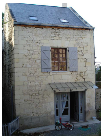
Figure 1-4 : Façade Ouest avec fissuration
