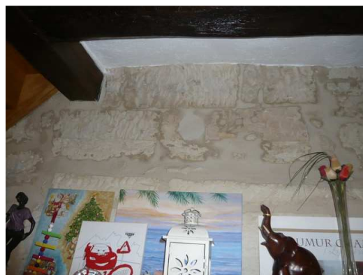
Figure 1-12 : Traces d'humidité sur le mur intérieur
