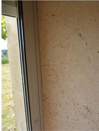
Figure 2-1 : Enduit chaux-chanvre
