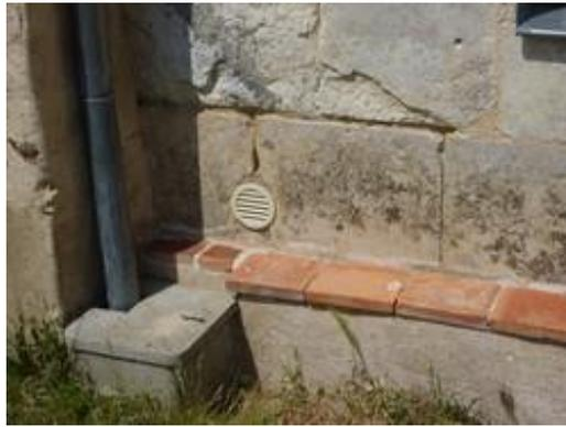
Figure 2-8 : Ventilation Sud du drain
