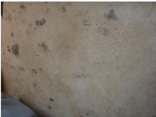
Figure 2-6 : Mur de refend partie XVIème/XIXème : enduit chaux-sable
