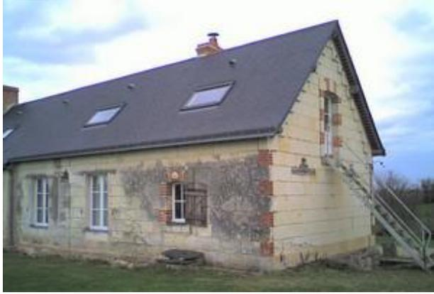
Figure 2-4 : Modifications des ouvertures de la façade Sud, partie XIXème (les deux de gauche)
