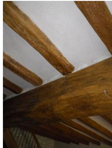
Figure 2-19 : Plafond du rez de chaussée
