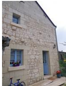
Figure 1-2 : Façade Ouest restaurée
