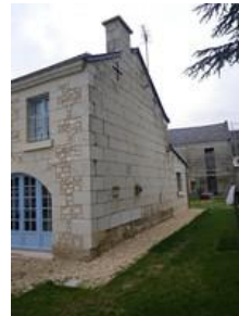
Figure 1-3 : Façade Est non rejointoyée
