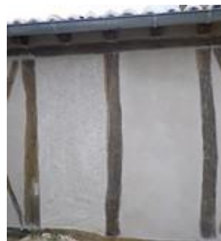
Figure 2-12 : mur à colombages de la nouvelle extension
