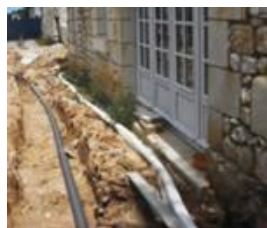
Figure 2-4 : Mise en place du drain
