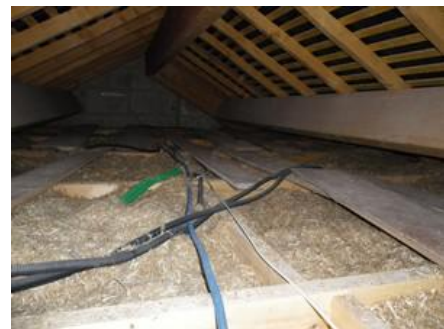
Figure 2-16 : Laine de chanvre des combles perdus
