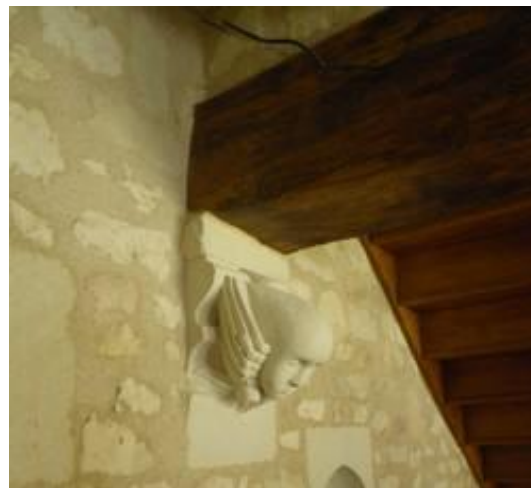
Figure 2-8 : Mur Nord avec boutisse sculptée portant la poutre
