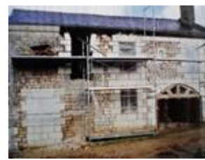
Figure 2-6 : Restauration de la façade Sud
