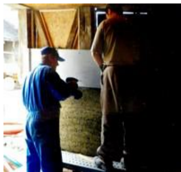
Figure 2-11 : Application de l'enduit banché
