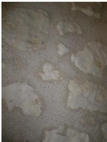
Figure 2-7 : Pierres de tuffeau apparentes, enduites de chaux, traces d'humidité
