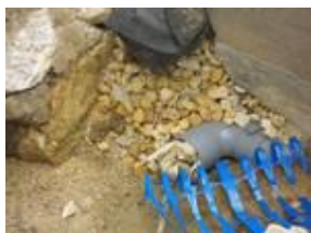
Figure 2-3 : Sortie du drain
