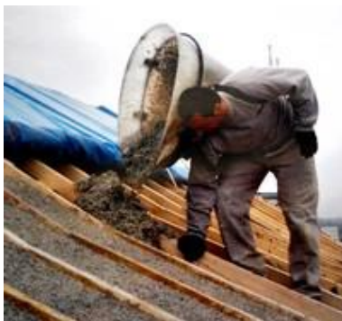
Figure 2-14 : Béton de chanvre coulé par le toit
