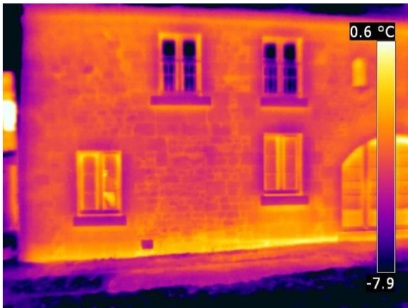
Figure 3-1 : Façade Sud vue par thermographie IR
