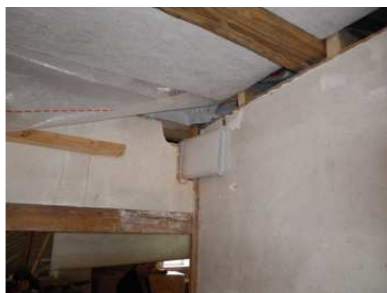
Figure 2-18 : Sortie de gaine rigide
