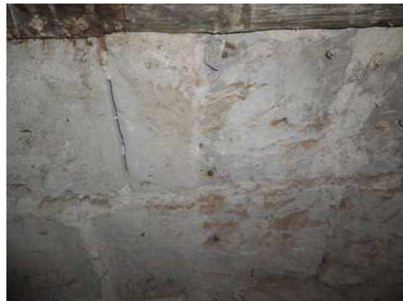
Figure 2-8 : Mur nain Sud : à gauche enduit ciment, à droite anciennement enduit ciment
