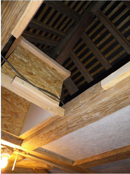
Figure 2-12 : Faux-plafond avant insufflation de ouate de cellulose
