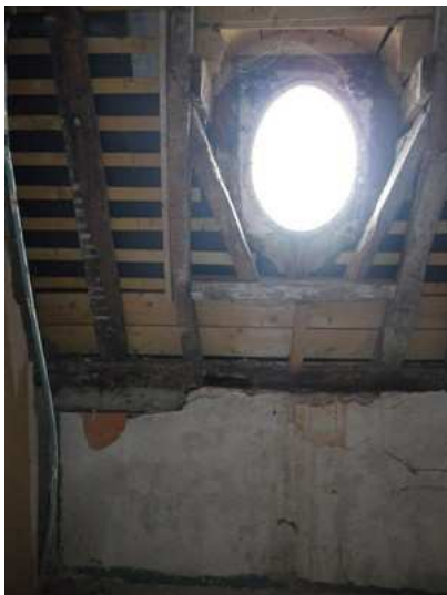
Figure 2-7 : Paroi Sud avant isolation
