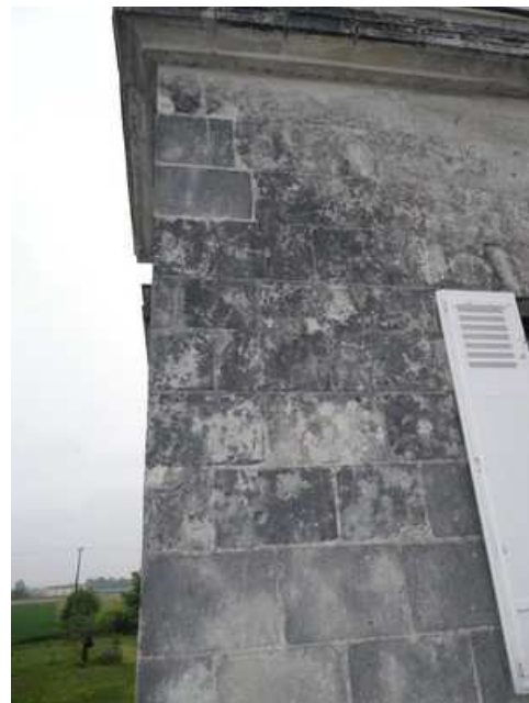
Figure 1-6 : Façade Sud recouverte de sulfin
