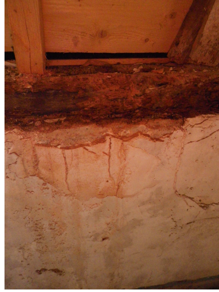
Figure 2-13 : Ancienne poutre sablière altérée
