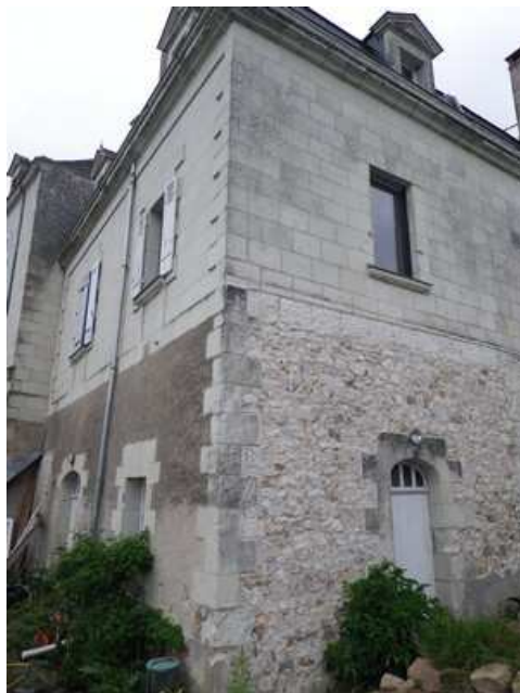
Figure 1-5 : Partie XIXème : enduit ciment sur la façade Nord (à gauche)
