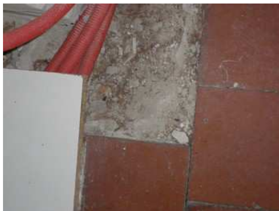
Figure 2-16 : Plancher en tomettes du rez-de-chaussée
