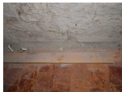
Figure 2-5 : Lisse de bois fixée le long du mur
