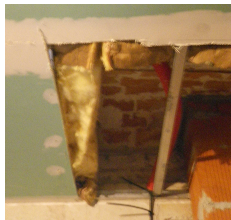
Figure 2-15 : Plancher du rez-de-chaussée vu du sous-sol (plafonnets + laine de verre)
