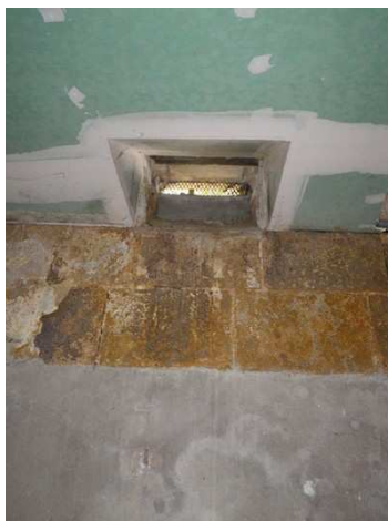
Figure 2-3 : Bouches d'aération vu du sous-sol, mur enduit de béton
