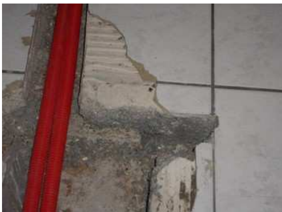
Figure 2-14 : Plancher dans une pièce du XIXème
