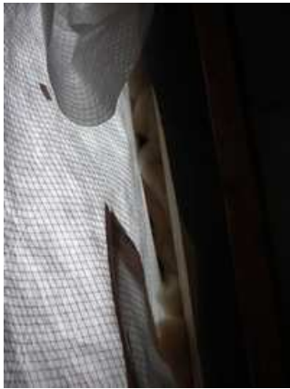
Figure 2-9 : Frein-vapeur et laine de mouton pour calfeutrer les fenêtres
