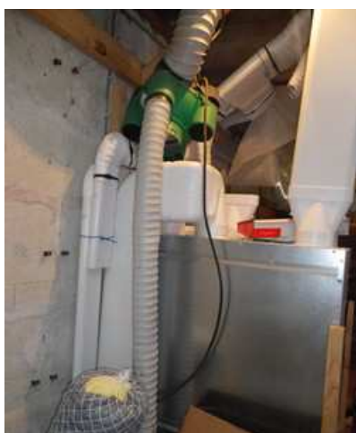
Figure 2-17 : VMC double-flux en cours de montage
