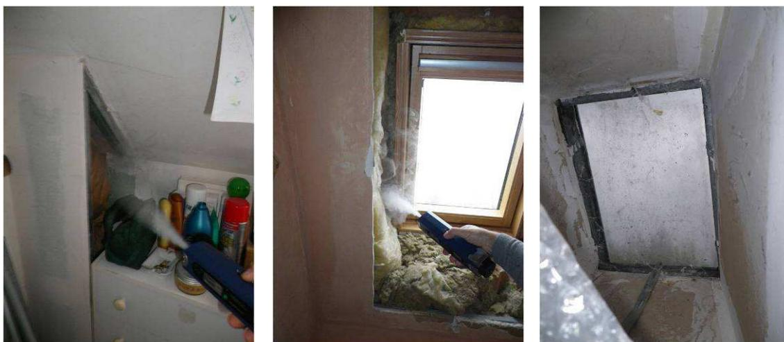
Figure 3-2 : Fuite par lanterneau dans l'escalier, absence de plaque de plâtre dans salle de bain et WC
