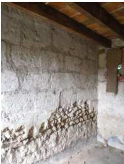
Figure 1-15 : Mur en silex puis tuffeau
