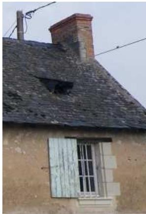
Figure 3-4 : Aération naturelle par les ouvertures en toiture
