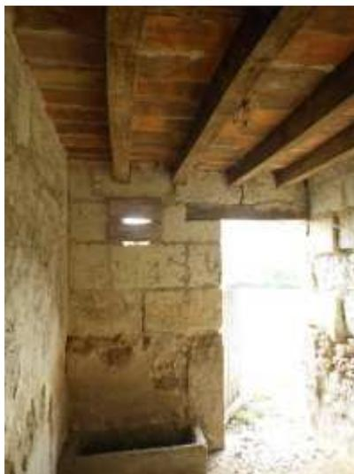
Figure 1-16 : Plafond en briques plâtrières sur solives
