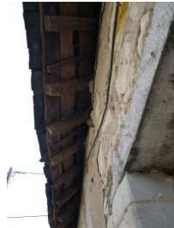
Figure 3-5 : Avancée de la toiture pour protéger des rayons et des intempéries
