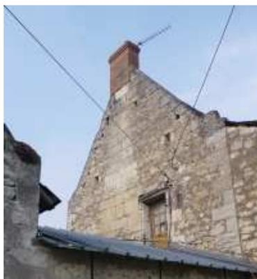
Figure 1-22 : Façade Est : pierre de taille pour le conduit de cheminée en briques
