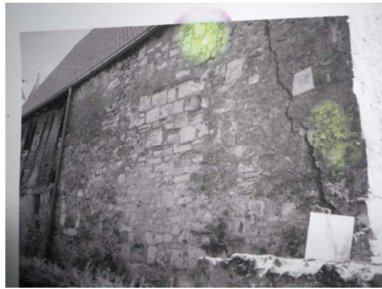
Figure 1-1 : Façade Ouest avant restauration
