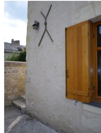
Figure 1-3 : Chaînage d'angle, vue de la façade Sud
