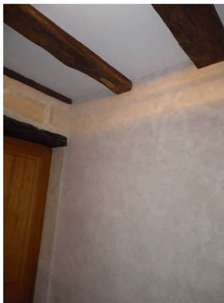
Figure 2-15 : Plancher intermédiaire vu du dessous - plaques de fermacell
