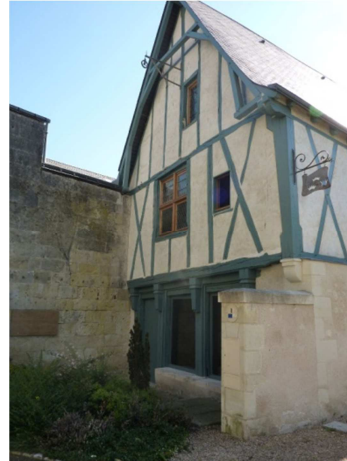
Figure 3-2 : Vue du Nord/Ouest
