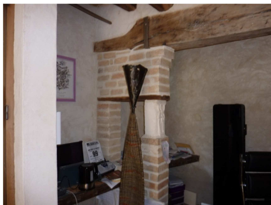
Figure 2-14 : Muret de brique qui renforce la poutre
