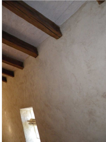
Figure 2-5 : Isolation en béton de chanvre sur murs et plafonds des combles
