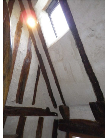
Figure 2-6 : Cage d'escalier : pans de bois en chêne et remplissage par béton de chanvre
