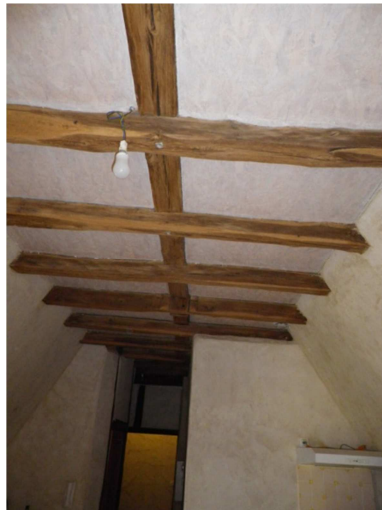
Figure 2-10 : Plafond sous combles
