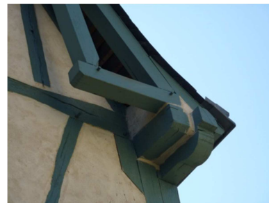
Figure 3-5 : Angle Nord/Ouest avec débord de la toiture
