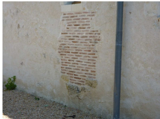
Figure 2-3 : Mur de briques, façade Ouest
