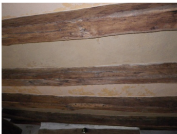
Figure 3-4 : Poutres réutilisées La toiture s'avance au-dessus des murs en tuffeau pour les protéger des pluies.
