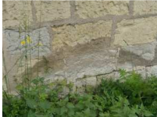
Figure 1-28 : Humidité sur le mur liée à l'absence de gouttière
