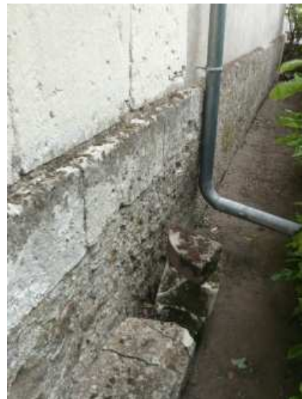
Figure 1-7 : Sous-bassement en pierres froides en saillie
