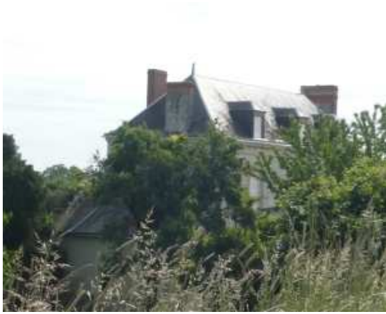
Figure 1-2 : Prise de vue Sud-Ouest
