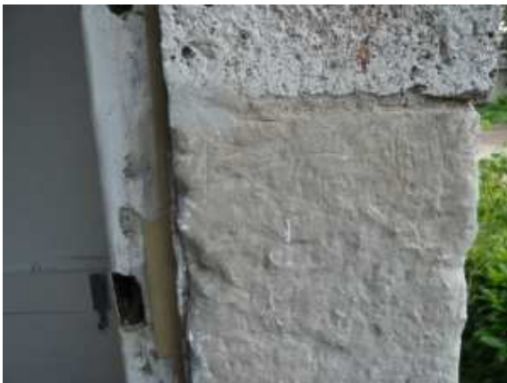
Figure 1-6 : Épaisseur de 22 cm des murs
