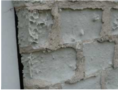
Figure 1-23 : Alvéolisation qui peut être liée à un rejointoiement par un mortier non adapté ou liée à un vieillissement des pierres
