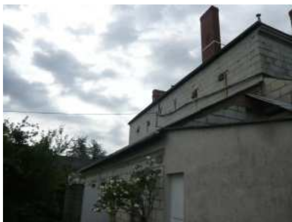
Figure 1-11 : Extension, angle de vue Nord-Ouest
