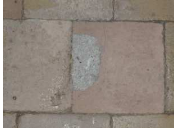
Figure 1-17 : Tomettes du plancher bas
