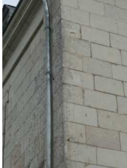
Figure 1-13 : Fissuration due à une différence de température entre la façade Sud "noire" et la façade Est "blanche"
