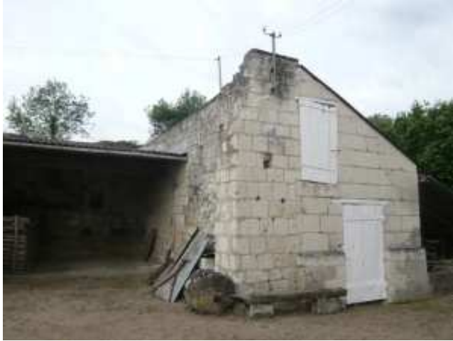
Figure 1-30 : Grange vue de la cour
