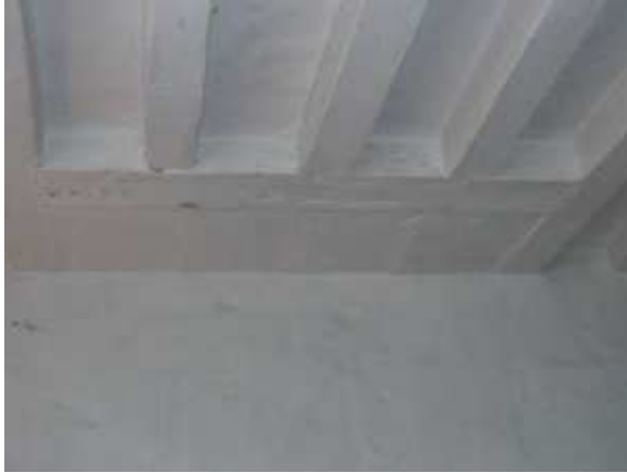
Figure 1-16 : Lait de chaux sur les murs et sur les planchers
