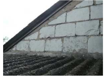
Figure 1-25 : Tuffeau jointé au ciment sur le pan Ouest
