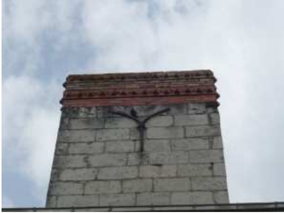
Figure 1-12 : Cheminée côté Est
