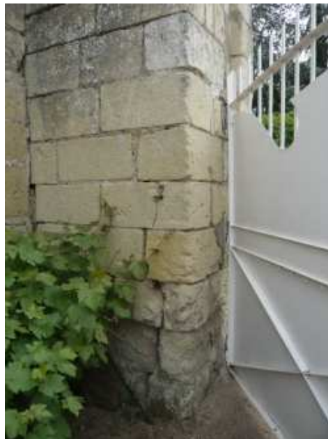
Figure 1-29 : Fissure du poteau qui sert à fixer le portail
