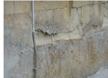
Figure 1-7 : Tuffeau détérioré à l'interface pierre de falun/tuffeau
