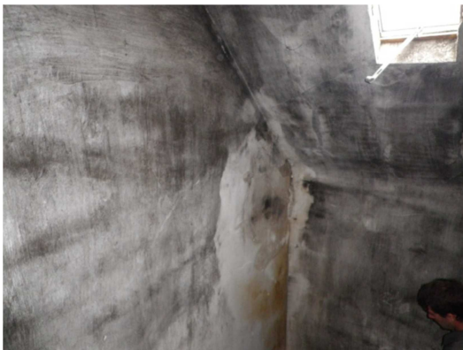
Figure 1-12 : Cage d'escalier recouverte de moisissures liées à une mauvaise ventilation
