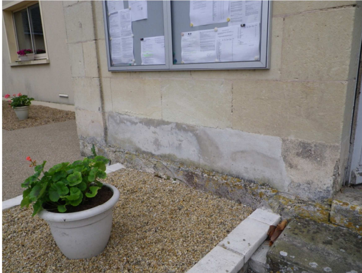
Figure 1-4 : Sous-bassement enduit de ciment
