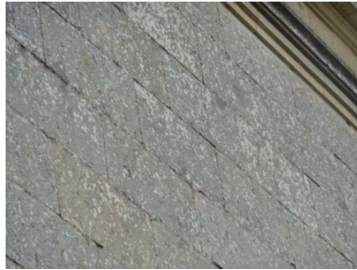
Figure 1-6 : Façade Sud avec croûte noire liée au rayons du soleil
