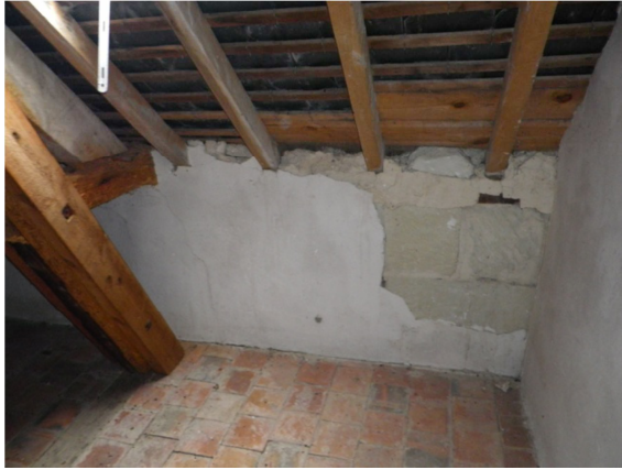
Figure 1-14 : Enduit plâtre dans les combles qui se détache par plaque
