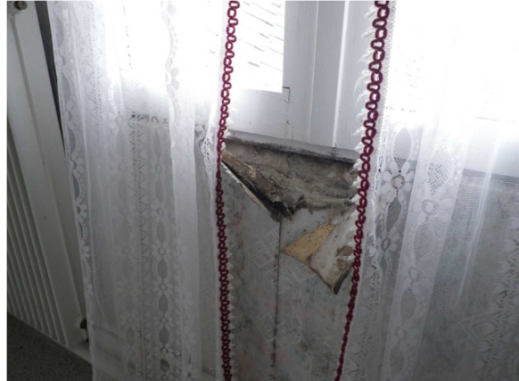
Figure 1-15 : Dessous de fenêtres subissant les infiltrations d'eau et les moisissures
