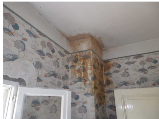
Figure 1-13 : Dégâts des eaux
