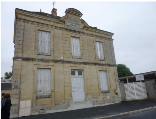
Figure 1-1 : Façade Ouest Forges
