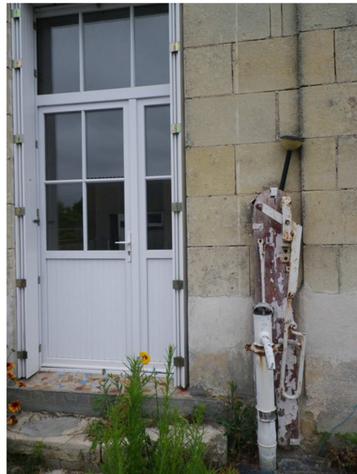
Figure 1-9 : Ouverture en PVC et puits (à droite)
