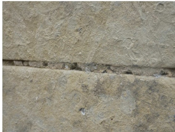
Figure 1-1 : Joints de chaux détériorés
