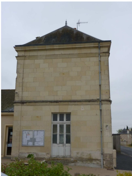
Figure 1-2 : Prise de vue Sud-Est
