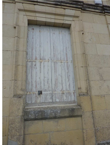
Figure 1-11 : Exemple d'ouverture avec appui de fenêtre ne permettant pas l'évacuation des eaux de pluie
