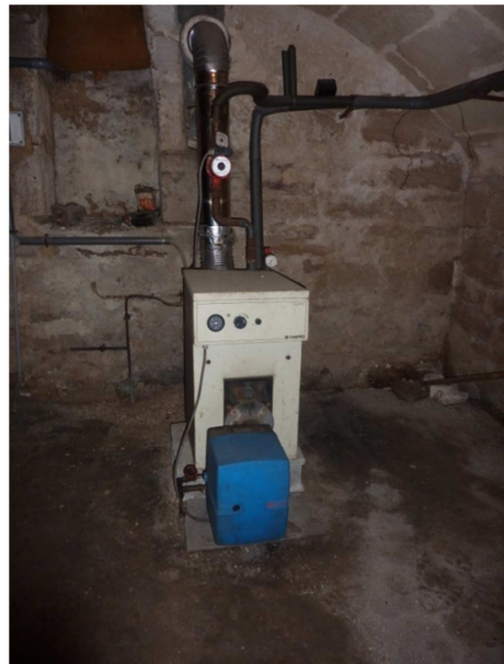
Figure 1-17 : Chaudière à fioul installée dans la cave
