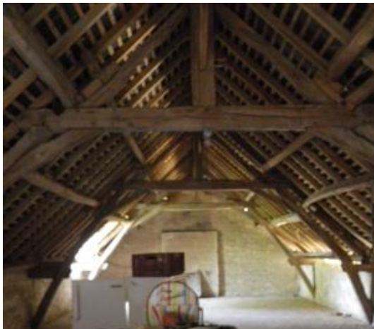
Figure 2-11 : Charpente permettant un aménagement
