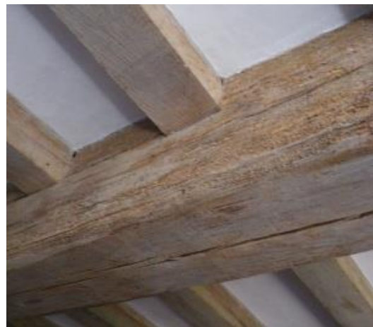
Figure 3-4 : Poutres du salon
