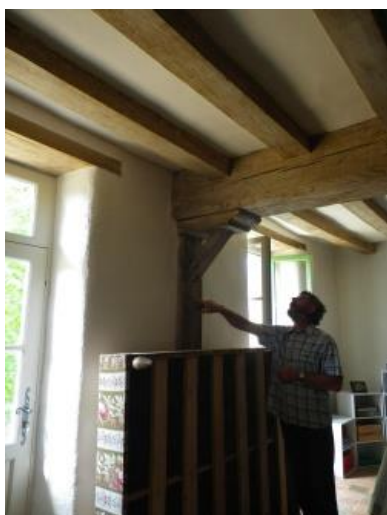
Figure 2-7 : Cordeau qui soutient la poutre du salon
