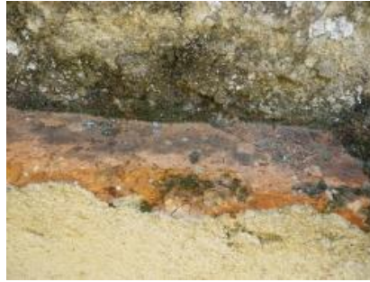
Figure 1-5 : Interface soubassement/tuffeau en argile
