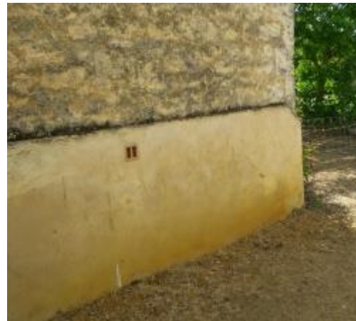
Figure 1-3 : Soubassement, façade Ouest
