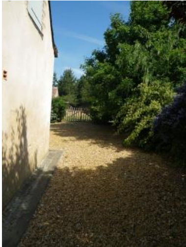
Figure 2-1 : Façade Est déterrée
