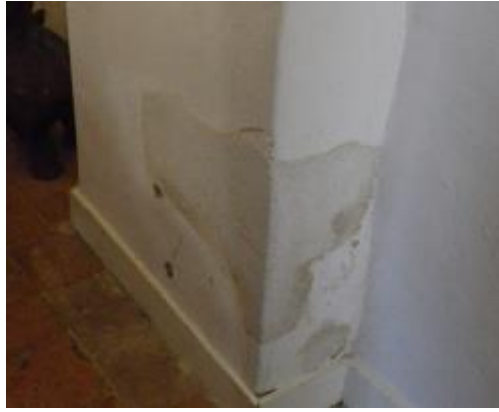
Figure 2-13 : Enduit de réparation
