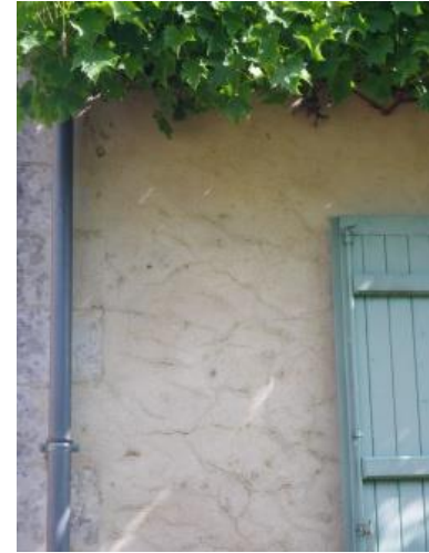
Figure 2-3 : Enduit au Sud craquelé
