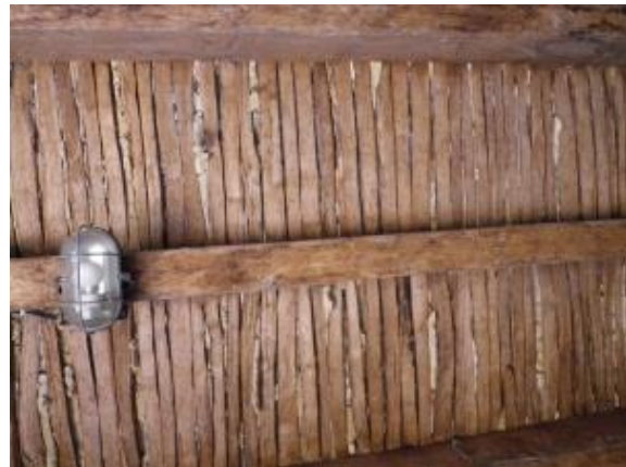
Figure 2-17 : Plafond de l'espace tampon en fusées de torchis simplifiées
