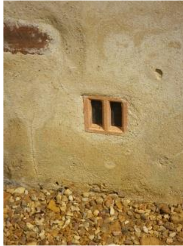
Figure 2-2 : Aération du drain
