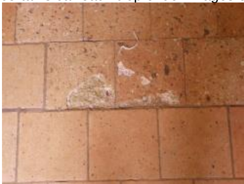
Figure 2-14 : Carreaux anciens et remplacés dans la cuisine
