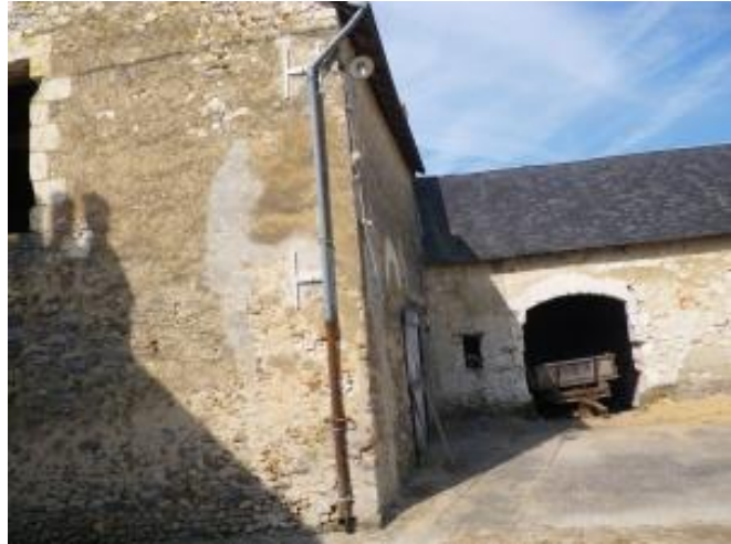
Figure 3-2 : Vue du pignon Ouest du bâtiment d'exploitation
