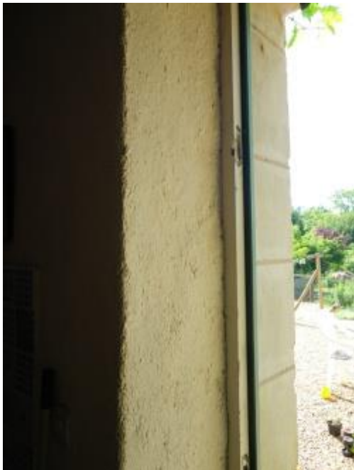
Figure 2-4 : Mur de la boulangerie couvert de chaux- chanvre
