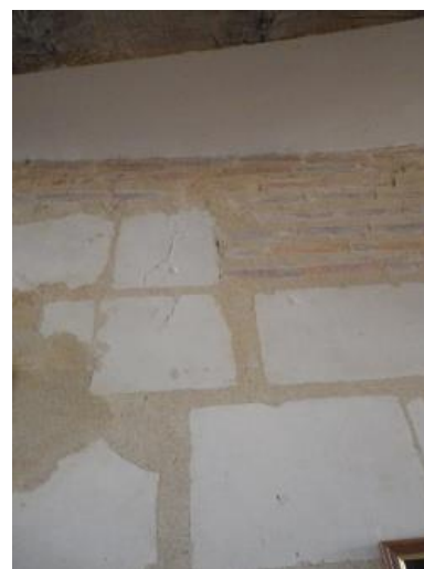
Figure 2-9 : Cloison en tuffeau et terre cuite
