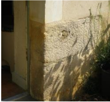
Figure 1-4 : Soubassement en grès
