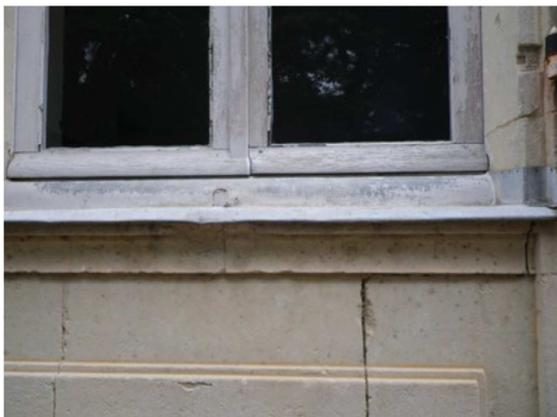
Figure 1-12 : Assise de fenêtre couverte de zinc
