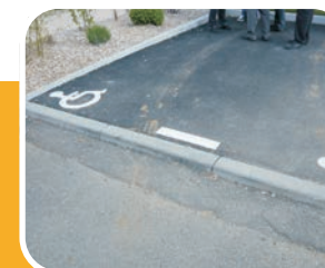
Place de stationnement inaccessible à cause du ressaut > 4 cm
