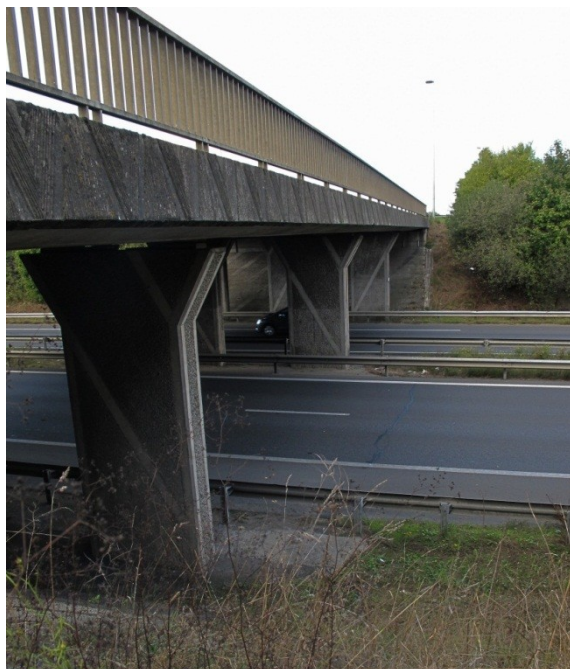
Pont sur le périphérique
