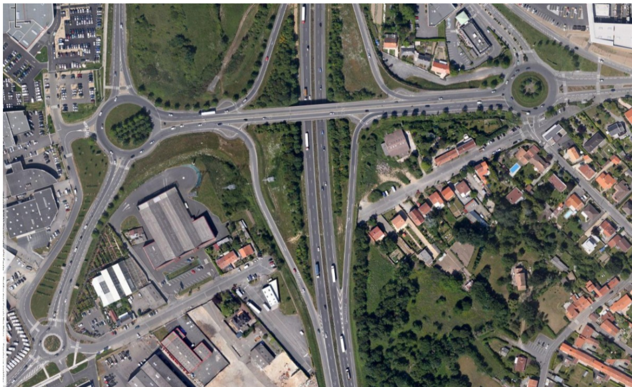
Figure 2 – Configuration actuelle du diffuseur de la porte de Rezé
