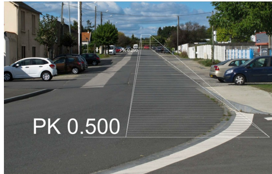
Rue James Joules : rampe de 200 mètres
