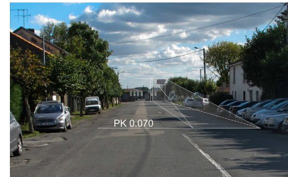
Rue des Bruyères : rampe de 120 mètres
