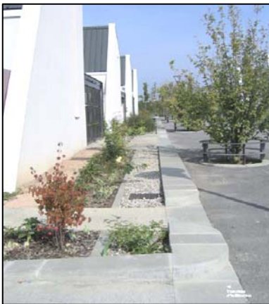
▶ Tranchées d'infiltration
