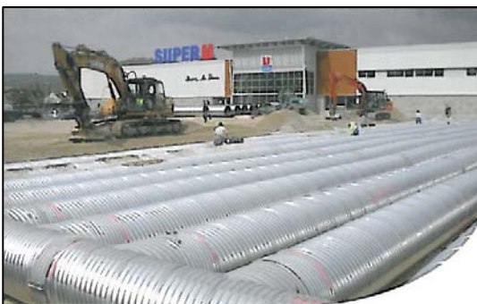
▶ Rétention EP visitable sous voirie SPIREL®- TURBISIDER
