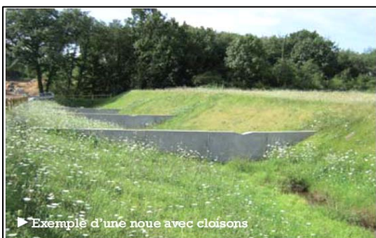
▶ Exemple d'une noue enherbée
