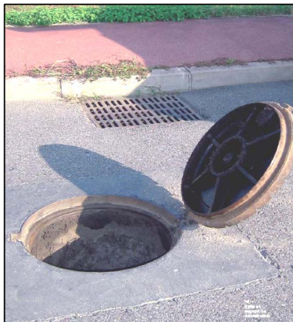
▶ Puits d'infiltration sur voirie (à éviter)
