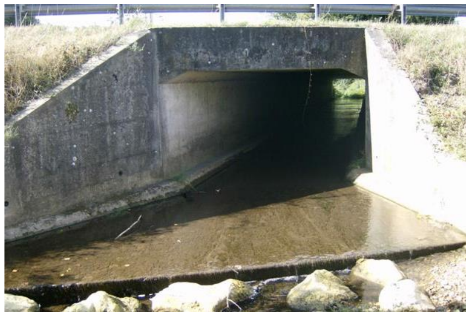
Etalement de la lame d'eau
