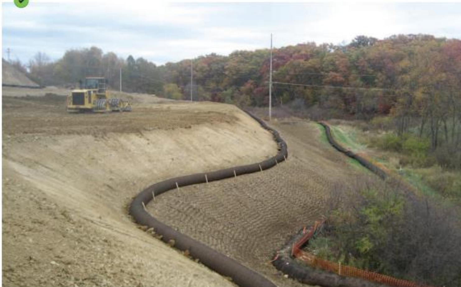
*Approche multi-barrières appliquée à un talus décapé : lutte contre l'érosion par chenillage des sols, infiltration des écoulements superficiels à l'aide de boudins de rétention en série, maintien d'une zone tampon entre le chantier et le cours d'eau par mise en défens de la ripisylve*
