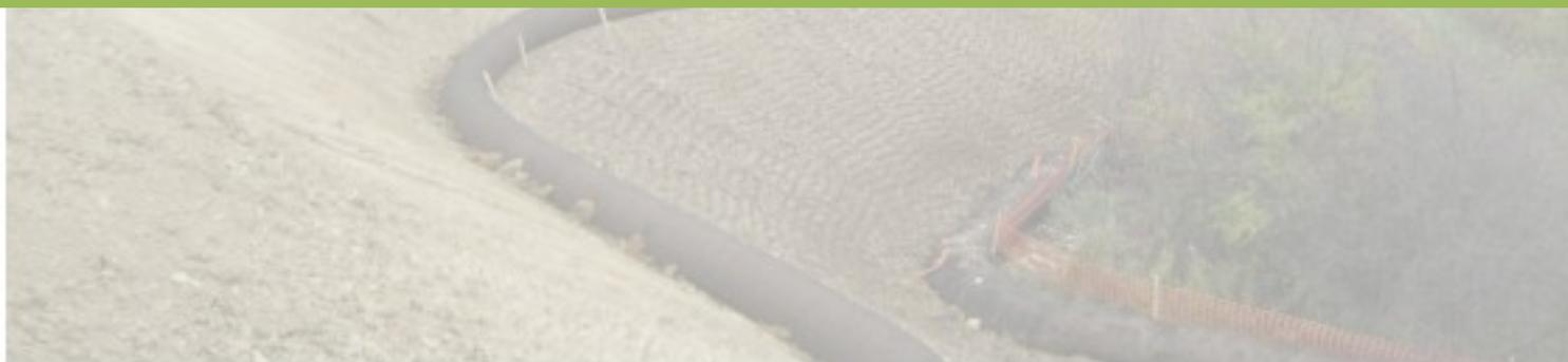
*Approche multi-barrières appliquée à un talus décapé : lutte contre l'érosion par chenillage des sols, infiltration des écoulements superficiels à l'aide de boudins de rétention en série, maintien d'une zone tampon entre le chantier et le cours d'eau par mise en défens de la ripisylve*
