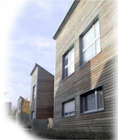
BARDAGE BOIS en pose à claire voie le long de la façade de serrureries. En protection des enytrées des logements.
