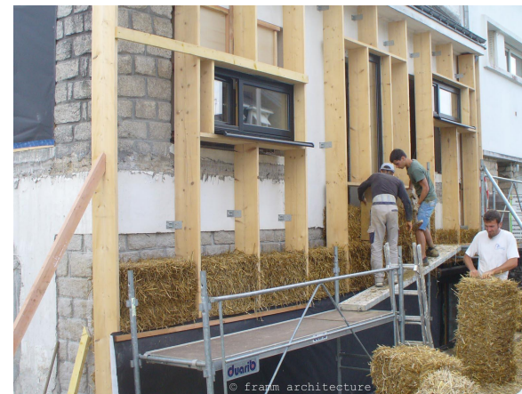
Isolation thermique extérieure Vannes (56)
