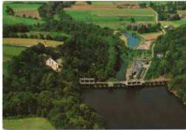
Barrage de Rophemel (Bretagne)
